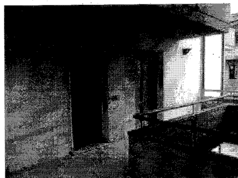
Pianerottolo vano scale condominiale e portone ingresso
