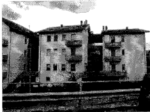
Vista fabbricato lato uscita superstrada
