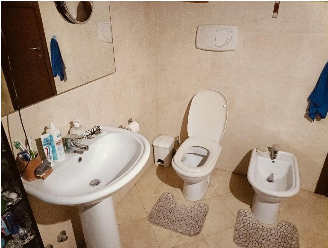
LOCALI SOTTOTETTO BAGNO
