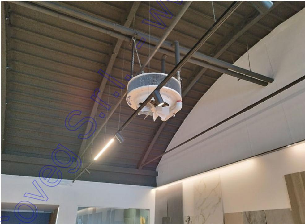
**Particolare riscaldamento con aerotermini**
