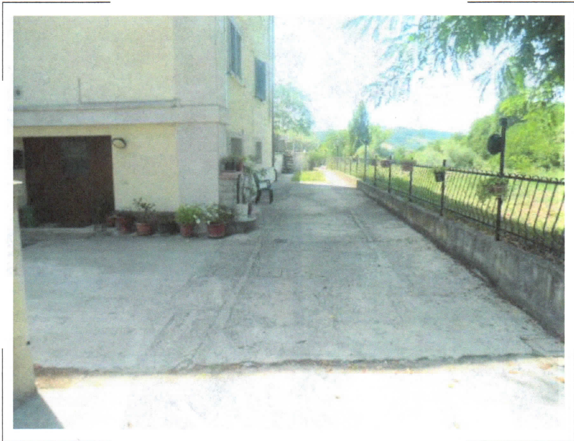
66) NCEU Fg.38 p.IIa 619 sub.1 - Vista generale della corte comune a servizio del complesso immobiliare di cui fanno parte i beni oggetto di stima
