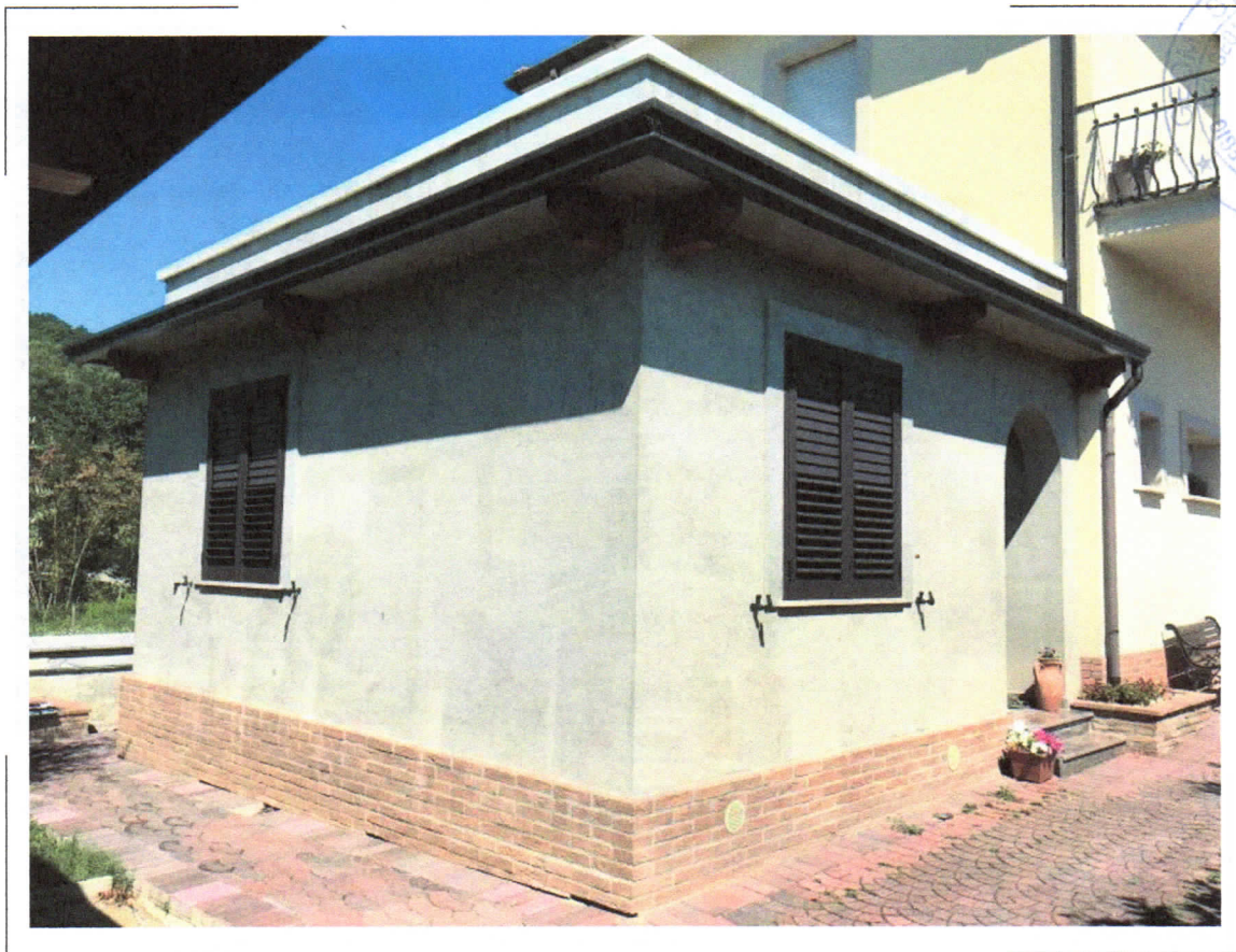
59) NCEU Fg.38 p.la 619 sub.1 (blocco 3) - Particolare della porzione di ampliamento adibito a soggiorno realizzato sulla corte comune (sub.1) del complesso immobiliare
