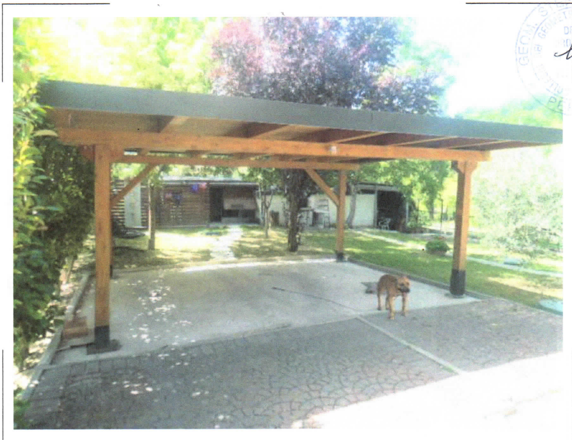
67) NCEU Fg.38 p.IIa 619 sub.1 - Vista generale della tettoia in legno edificata sulla corte comune del complesso immobiliare di cui fanno parte i beni oggetto di stima
