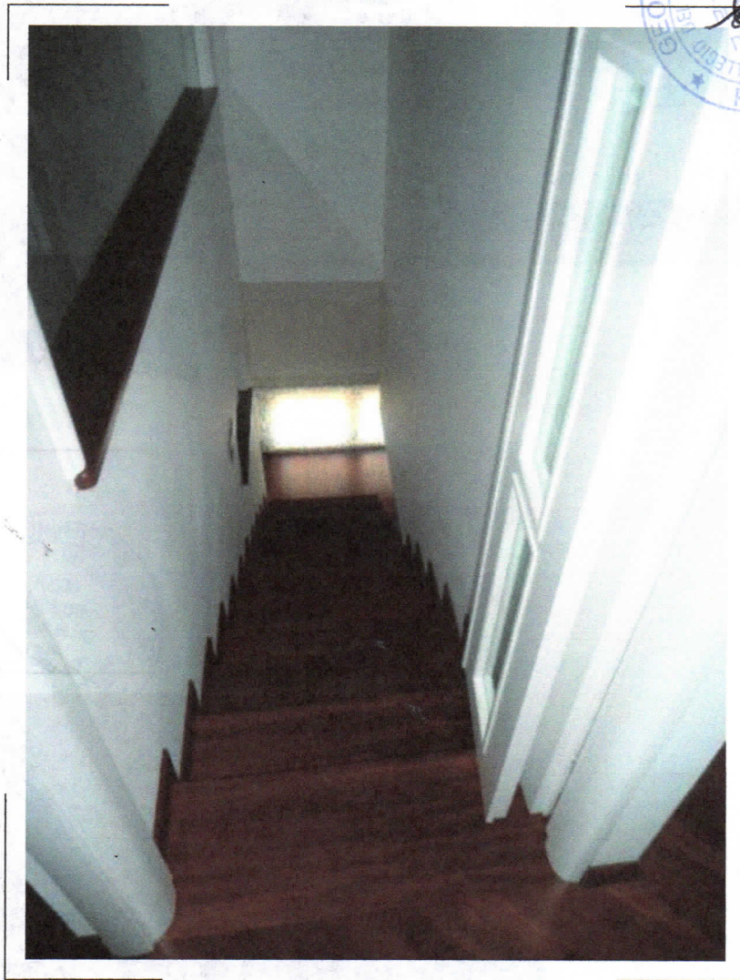
49) NCEU Fg.38 p.IIa 619 sub.5 (blocco 2) – Particolare della scala ad uso esclusivo che collega la porzione di ampliamento al piano primo (ex terrazzo di mq.69,00 circa) al locale garage al piano terra (Fg.38 p.IIa 619 sub.3 trasformato anch'esso in cucina ed oggetto di stima)
