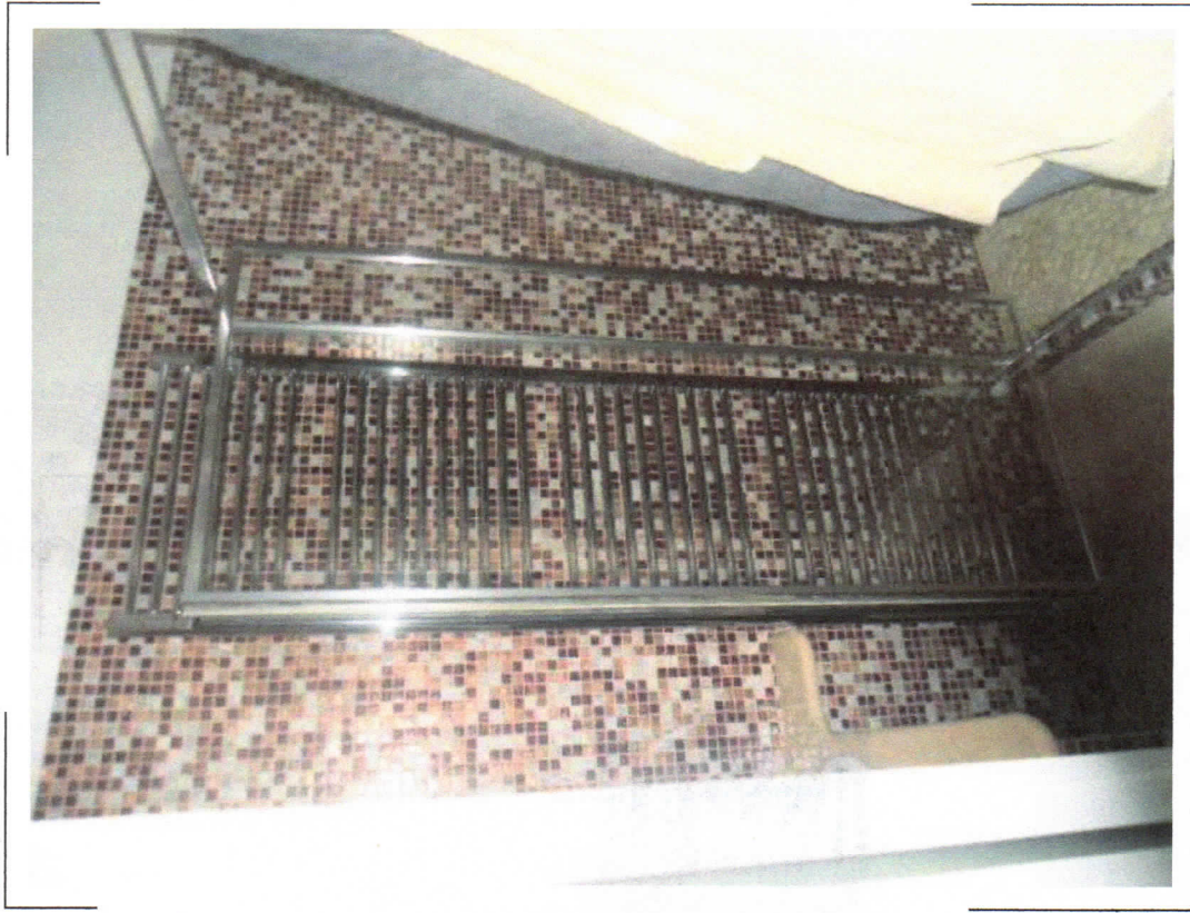
46) NCEU Fg.38 p.IIa 619 sub.5 (blocco 2) – Particolare del w.c. al piano primo, realizzata su ampliamento (ex terrazzo di mq.69,00)
