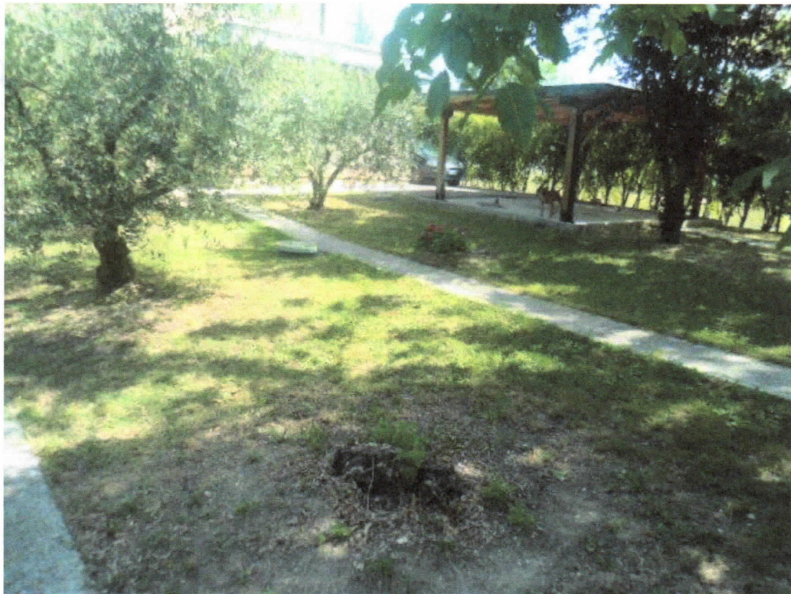
64) NCEU Fg.38 p.IIa 619 sub.1 - Vista generale della corte comune a servizio del complesso immobiliare di cui fanno parte i beni oggetto di stima
