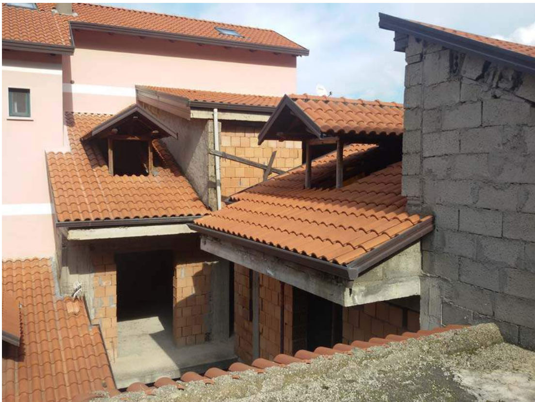
Vista esterna dei sottotetti
