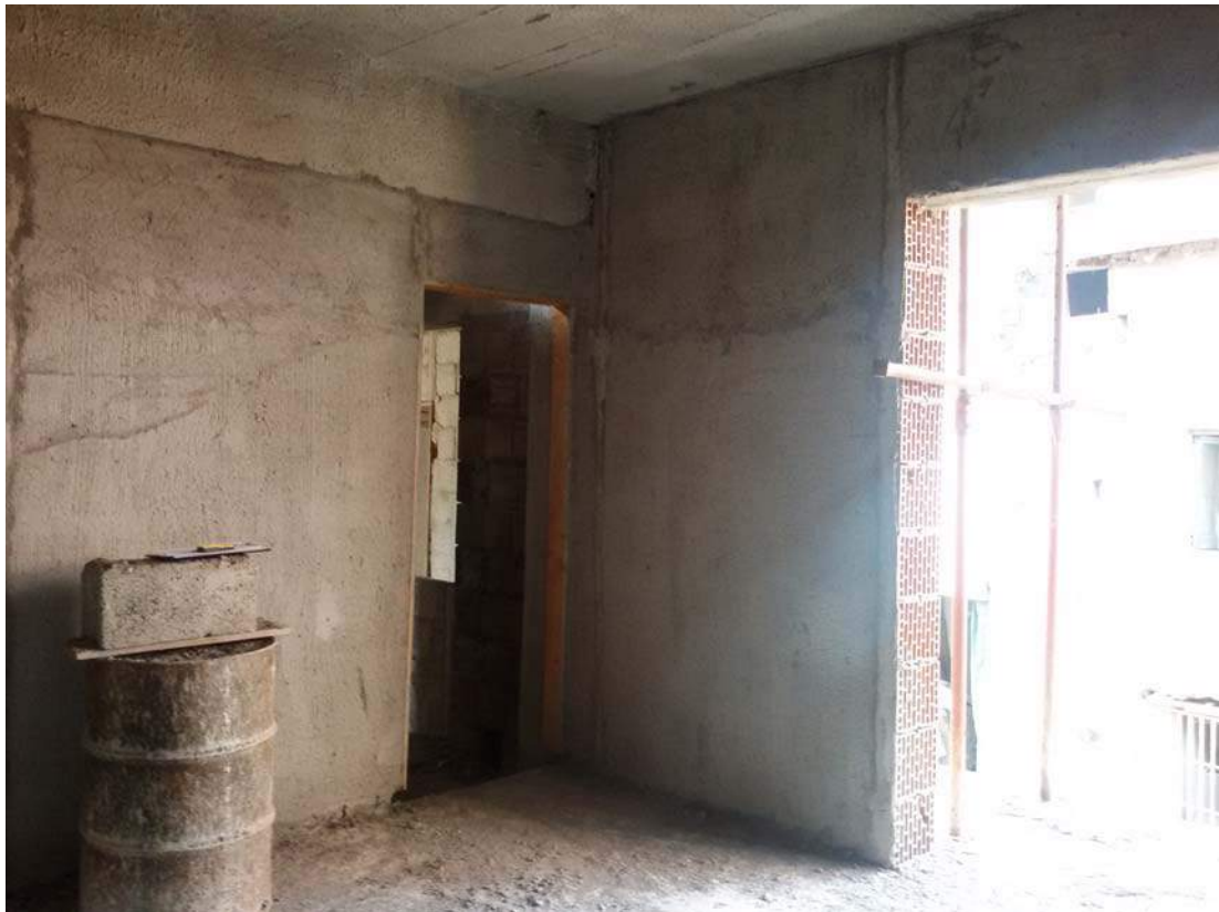
Vista d'insieme del Locale 10
