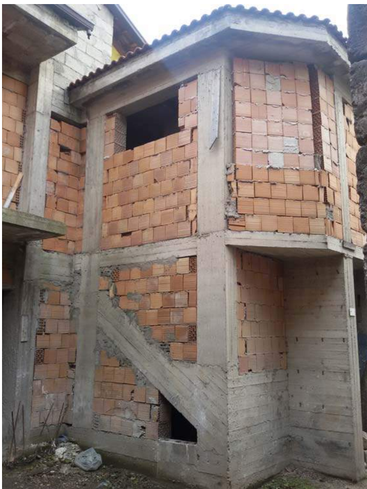
Prospetto edificato su cortile interno
