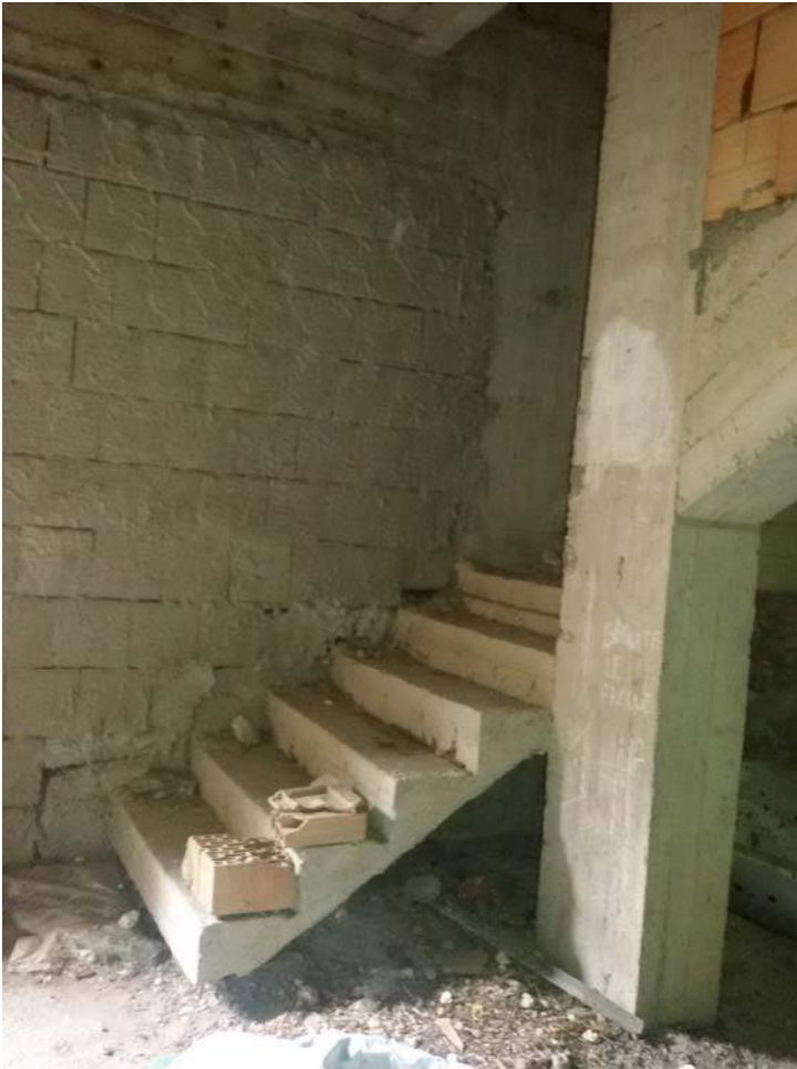
Scala che conduce al piano primo
