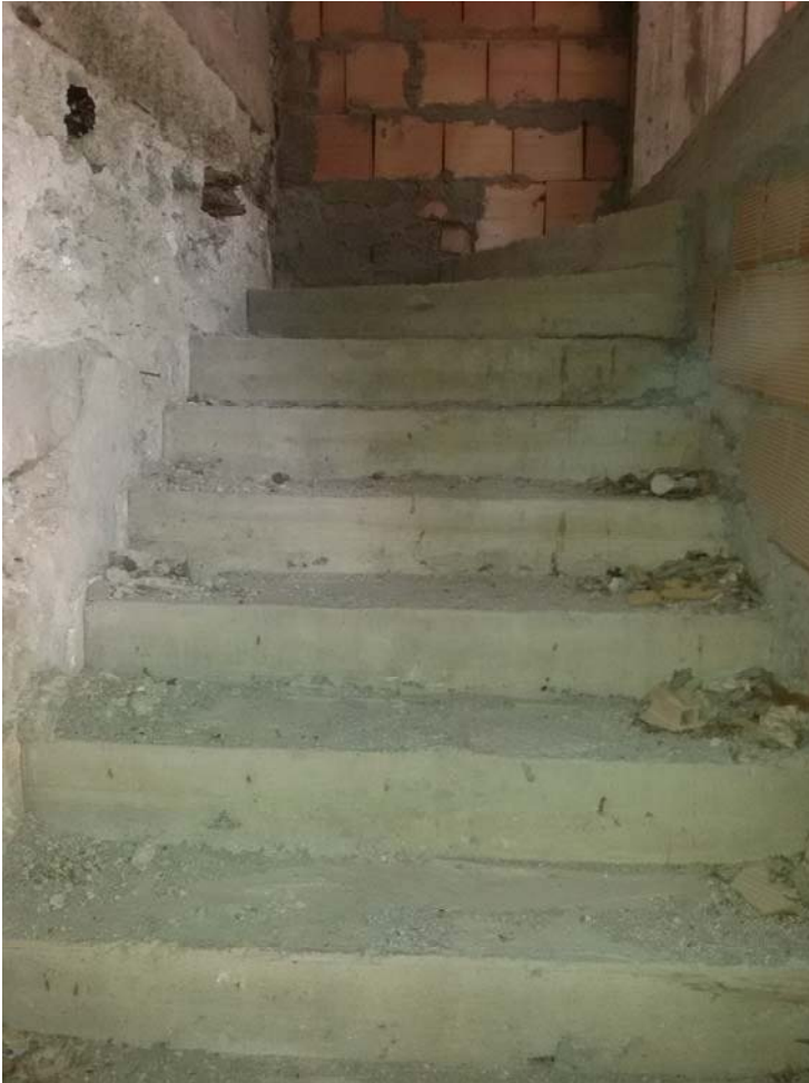
Scala che conduce ai sottotetti
