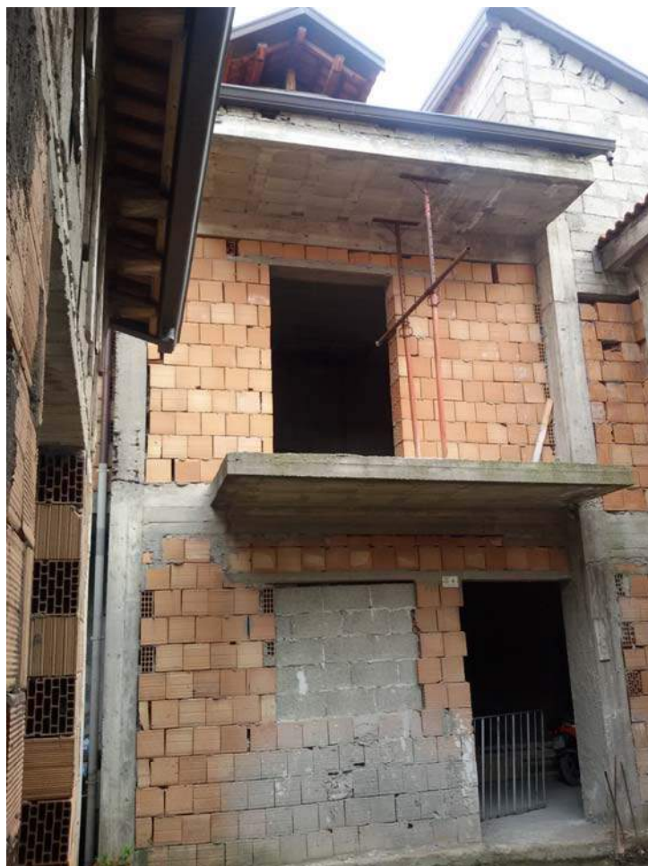
Prospetto edificato su cortile interno
