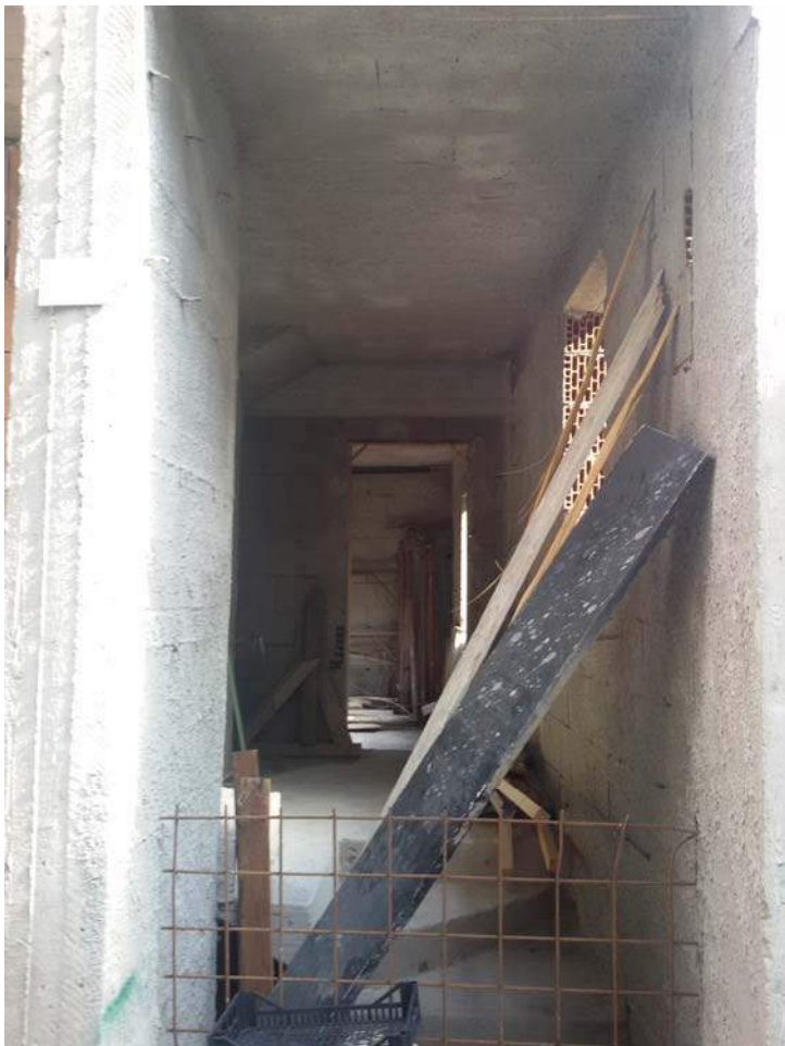
Vista d'insieme del locale 2
