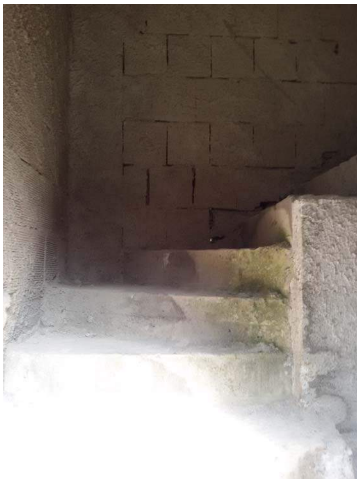
Scala che conduce al piano primo
