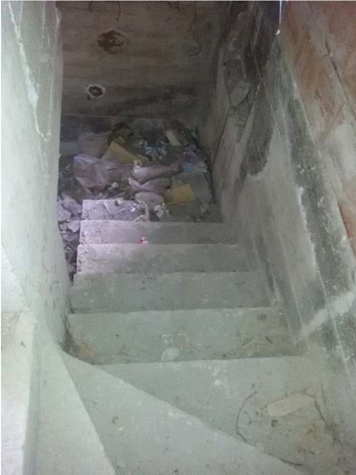
Scala che conduce al cantinato
