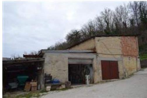
Vista del manufatto attualmente utilizzato a magazzino agricolo e rimessa area di sedime in pendenza, con terreni agricoli adiacenti o prossimi ad esso
