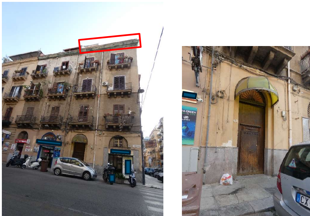
Prospetto e portone di ingresso condominiale su via Isidoro Carini 68
