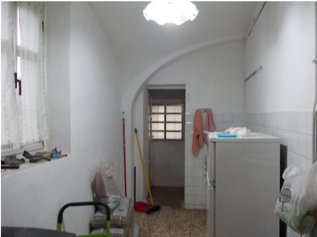
Foto 12 Locale sgombero sub.1 p.t.
