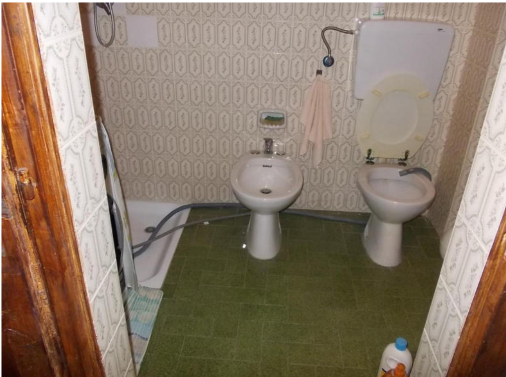
Foto 16 Locale w.c. da regolarizzare sub.1 p.t.
