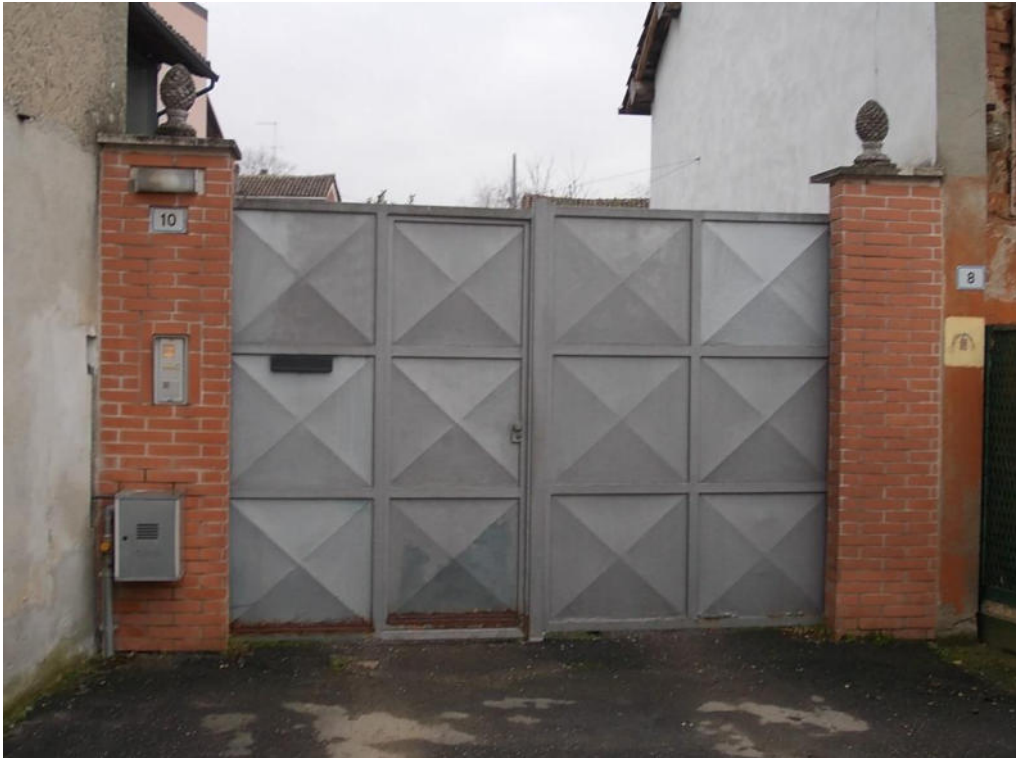
Foto 1 Cancellone ingresso da Vicolo Monzambano civ.10
