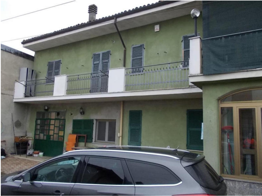
Foto 3 Prospetto ovest fabbricato mapp.371 sub.1,sub.2
