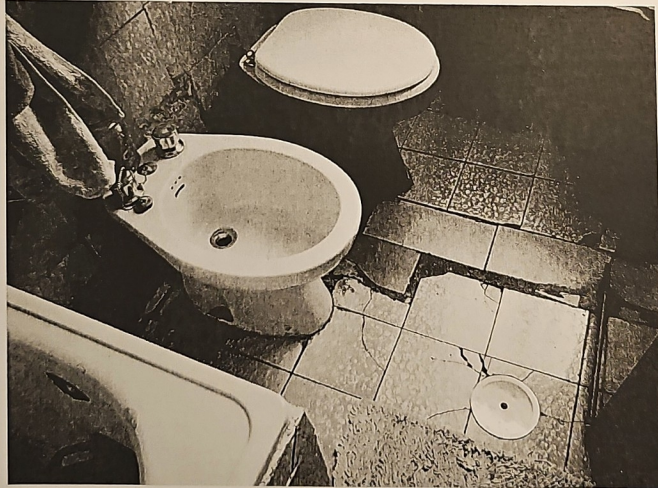
Particolare servizio igienico
