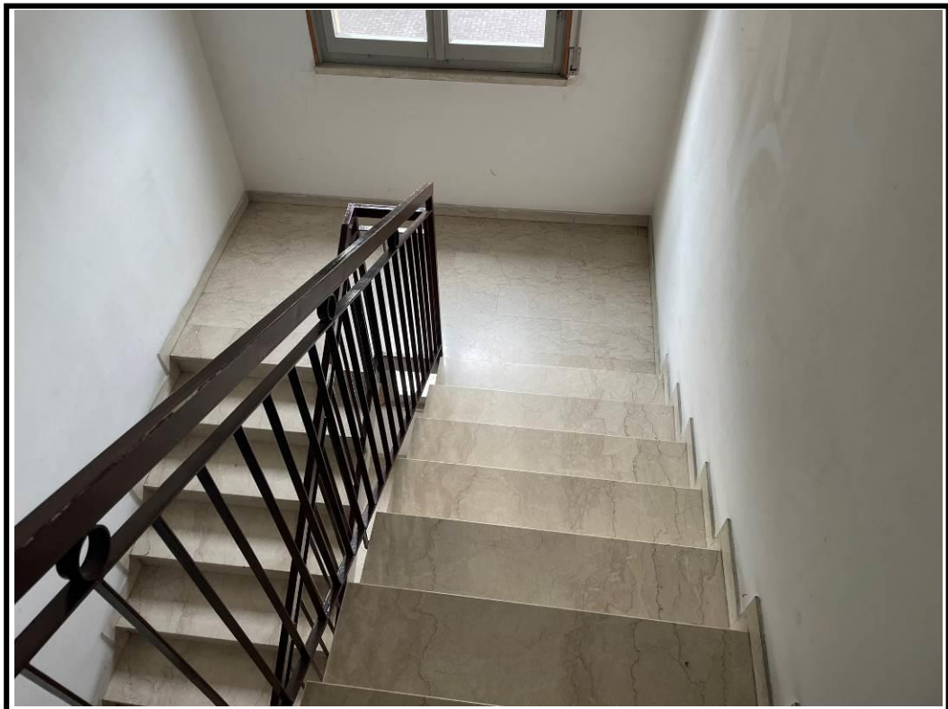
Foto 10 Vano scala comune
