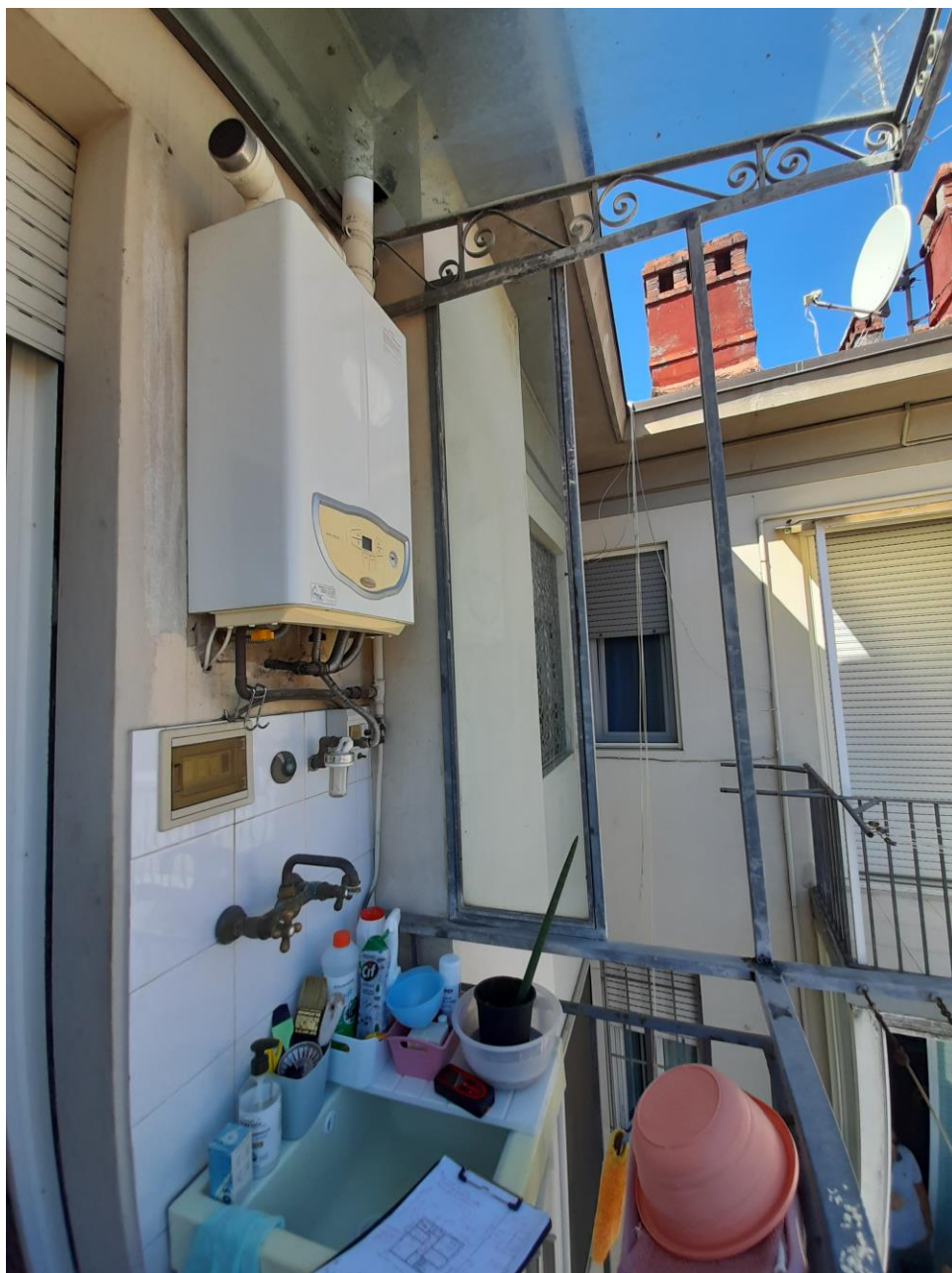
Foto n. 4 – Balcone coperto di proprietà posto sul retro
