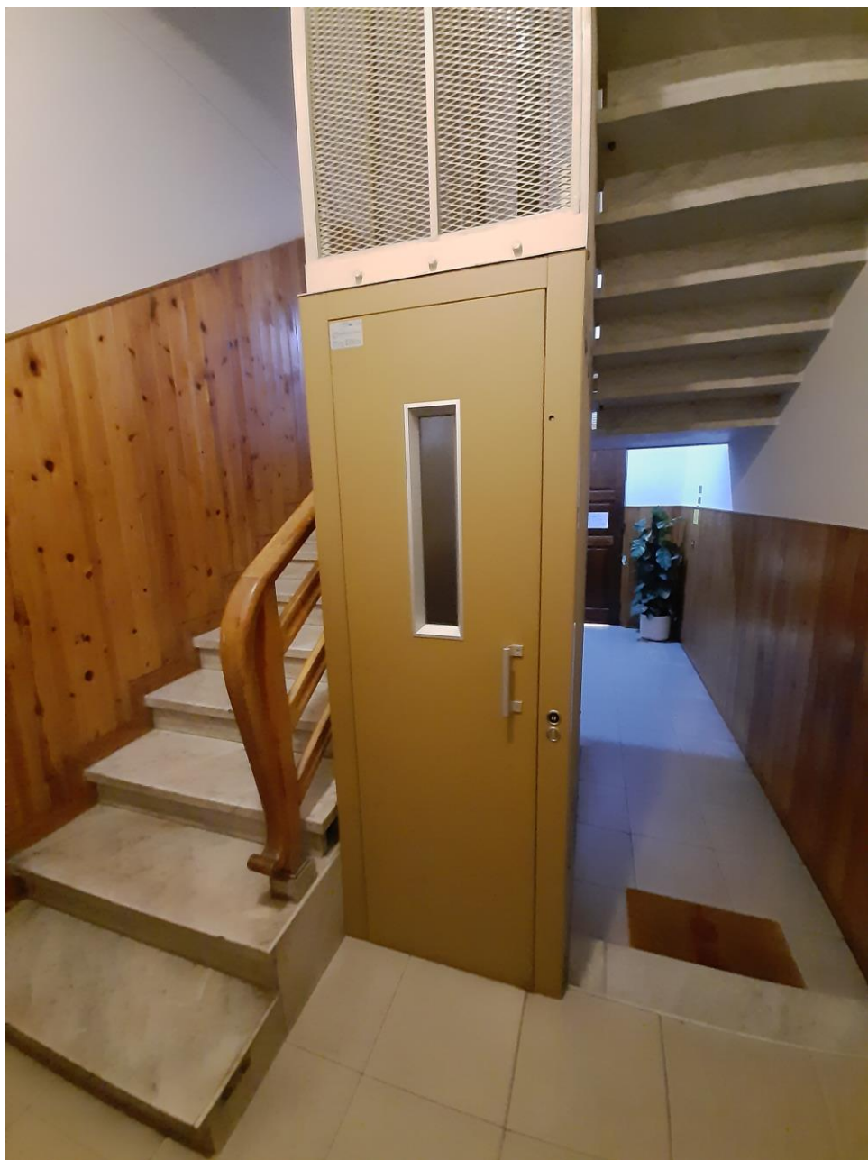
Foto n. 8 – Vano scala ed ascensore condominiali
