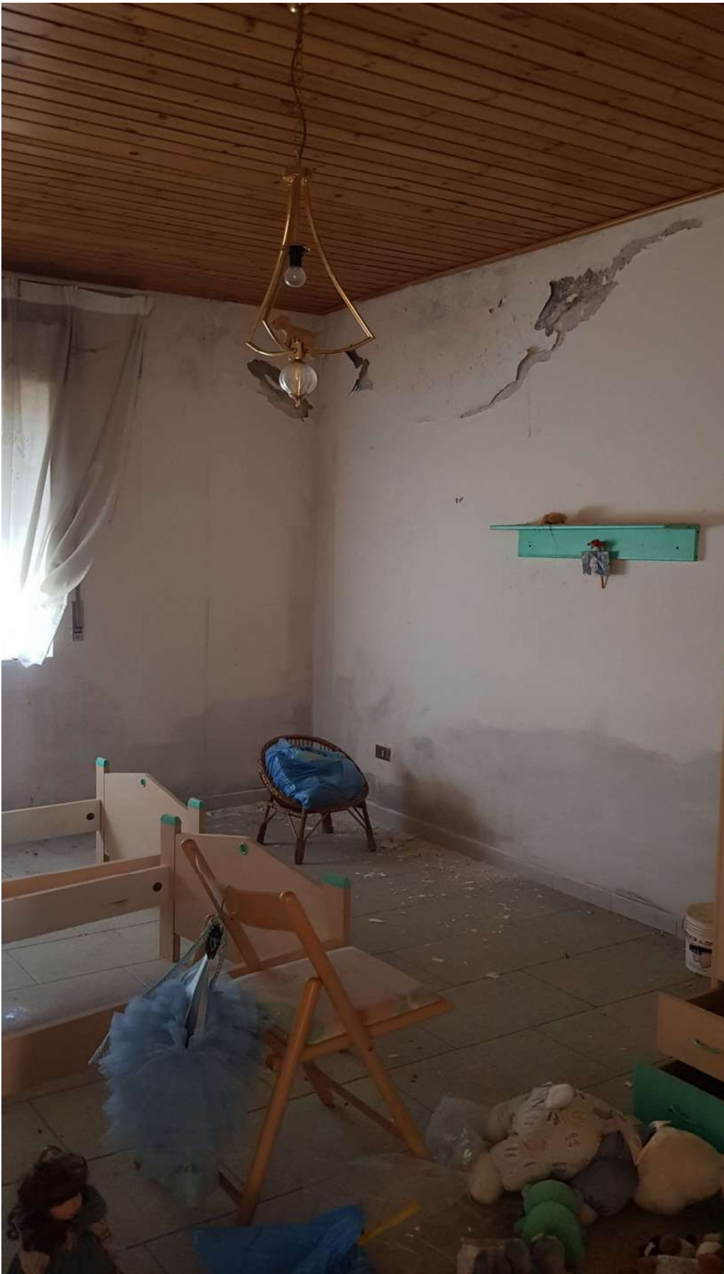
FOTO 8 LOTTO 1 - Fabbricato in Scampitella (AV): FG 20; P.lla 629 sub 2 camera Piano Primo
