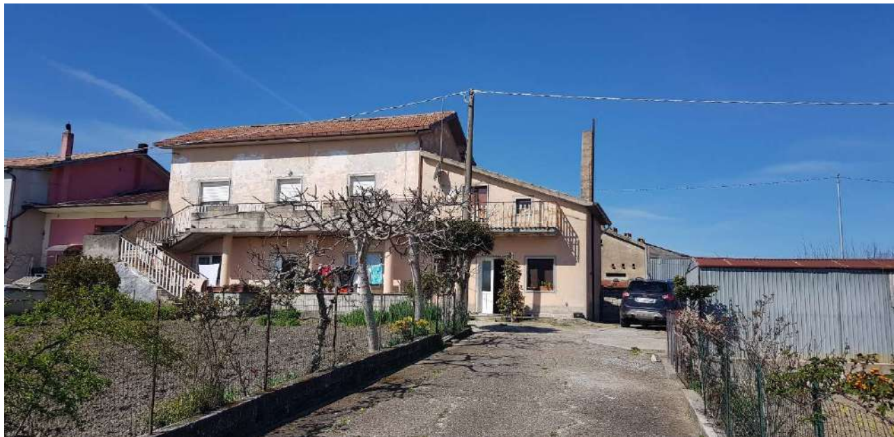
LOTTO 1 - Fabbricato in Scampitella (AV): FG 20; P.lla 629 sub 2 Via Citta' di Contra 278
