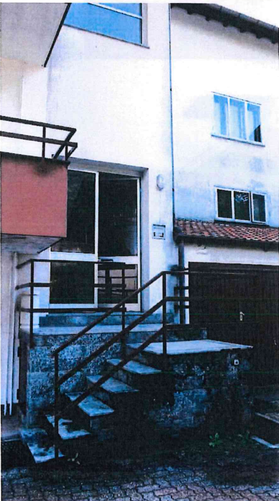
Ingresso condominiale da cortile
