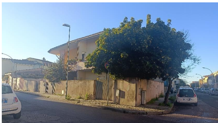
Vista esterna dell'edificio, angolo via Laconi/ via Olbia.
