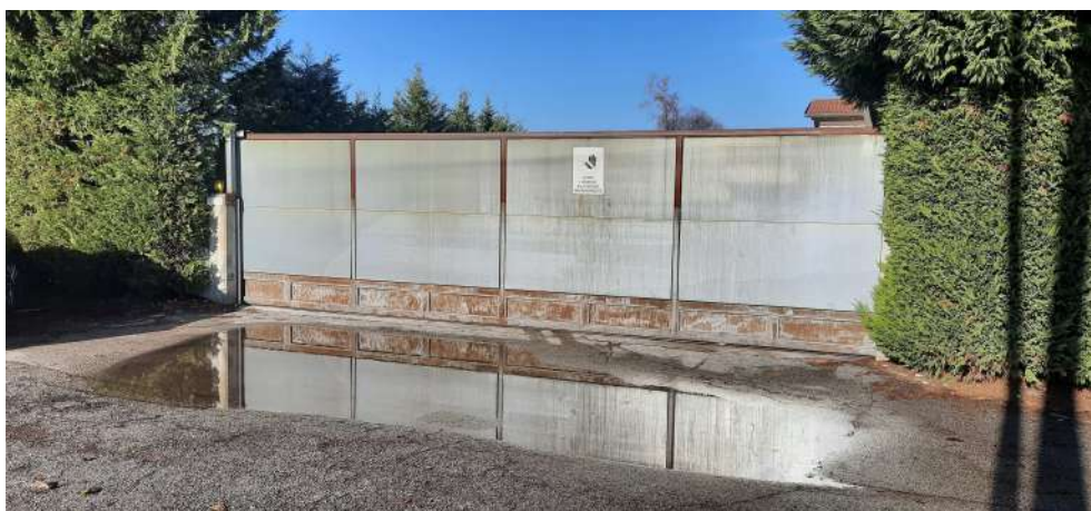
Figura 21 accesso pedonale e carraio da via Strada del Confine snc
