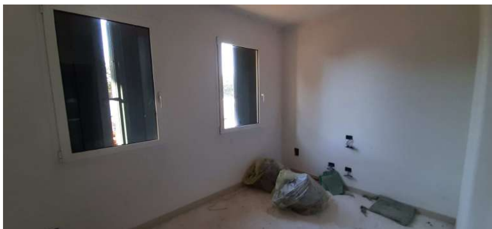
Figura 11 locale camera OVEST
