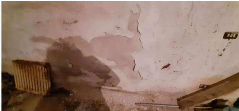
Figura 32 dettagli problemi infiltrativi al Piano Interrato
