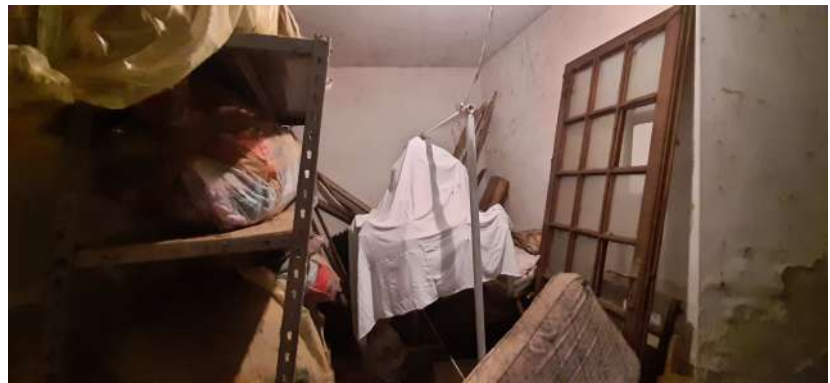
Figura 31 locale cantina al Piano Interrato
