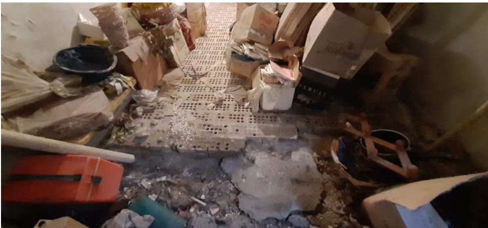
Figura 33 dettagli finiture al Piano Interrato
