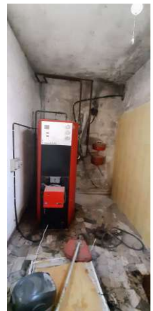
Figura 28 locale lavanderia e C.T. al Piano Interrato con vecchia caldaia a gasolio in disuso
