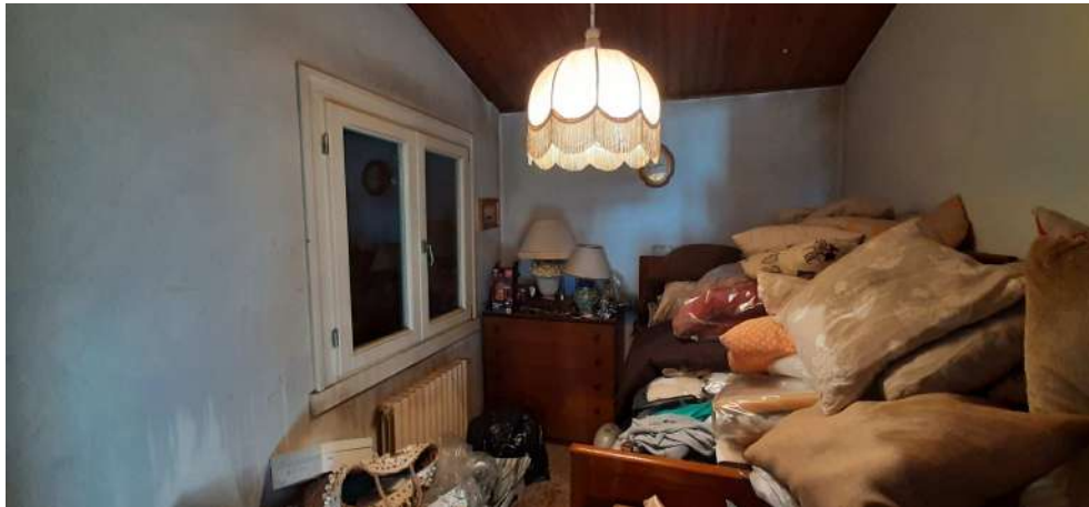
Figura 22 locale camera ovest al P1
