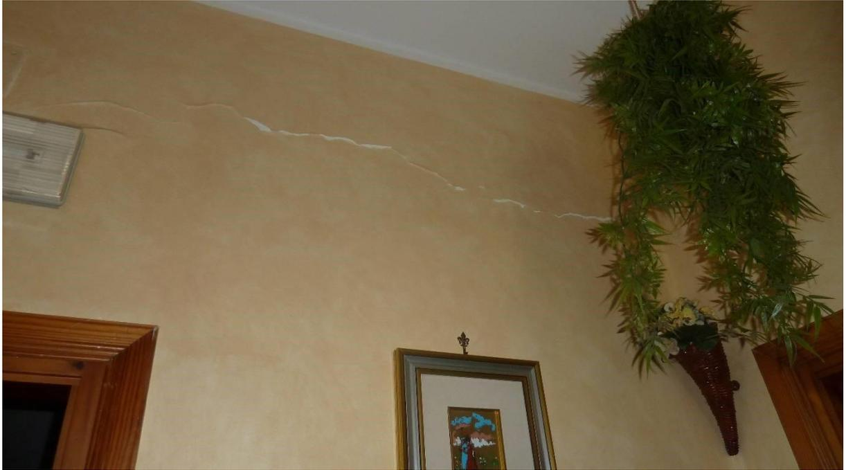
**Figura 18** – La parete divisoria di fondo, posta a confine col bagno, mostra vistosi segni di assestamento, non strutturale.
