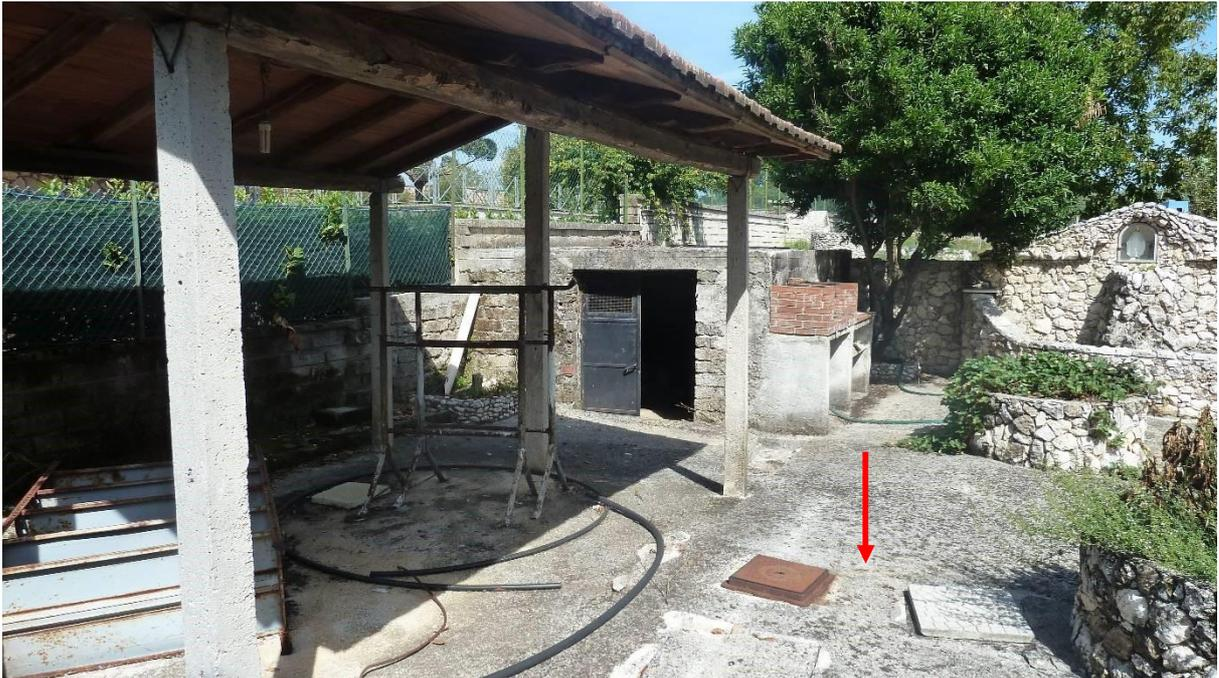
**Figura 5** – La servitù di servizi comprende il deflusso degli scarichi domestici anche provenienti dal confinante di sinistra, cui la proprietà si svolge oltre la rete verde visibile in fotografia. Sono visibili a terra in primo piano, tre pozzetti di raccordo ed ispezione delle tubazioni dell'impianto.
