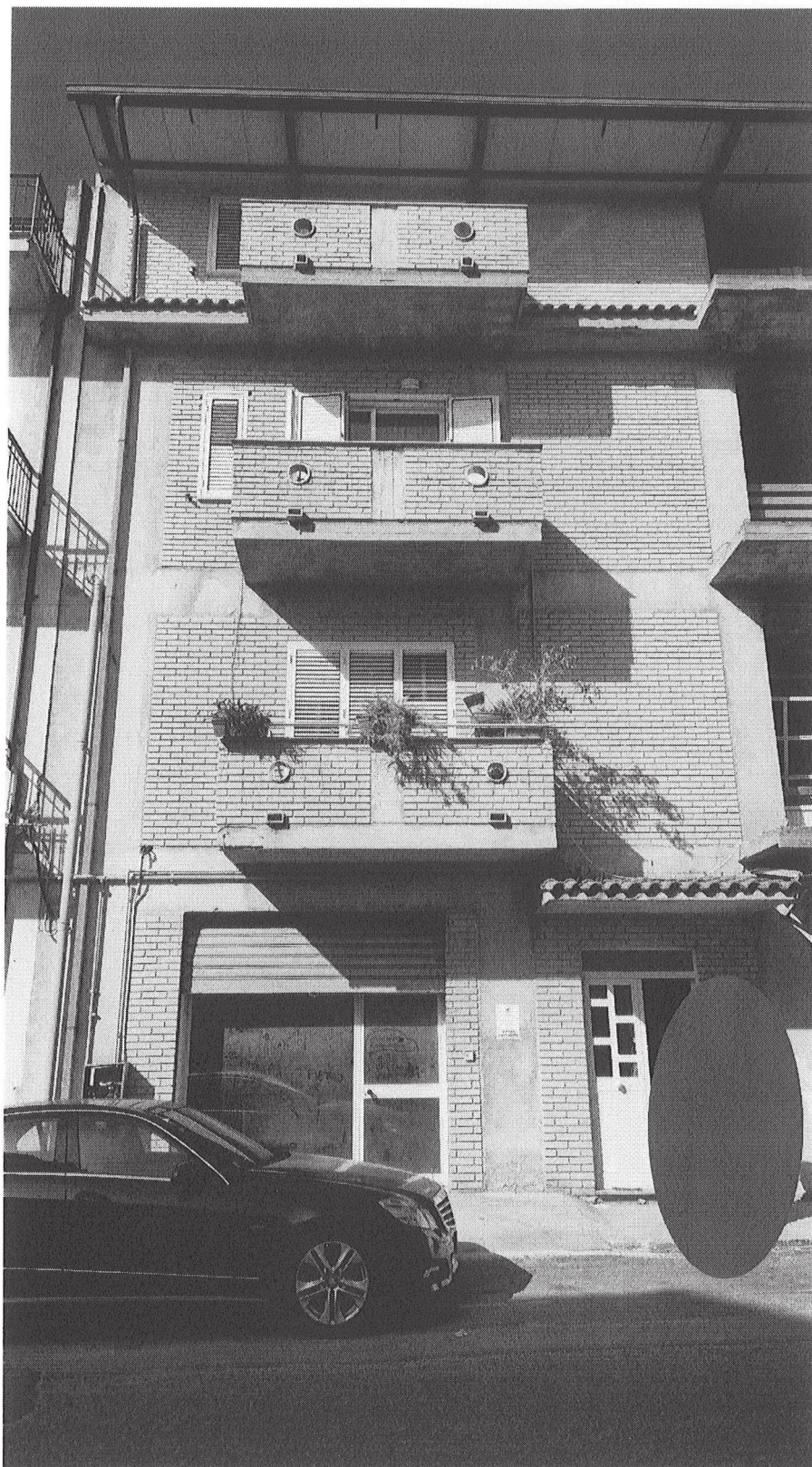
Foto n. 1 - prospetto su via Trieste
