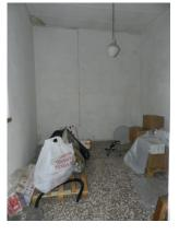
L'appartamento ha pavimenti in cotto, monocottura e graniglia, ha pareti intonacate e tinteggiate ed al suo interno presenta tracce d'umidità anche a pavimento . I serramenti delle finestre sono stati sostituiti
