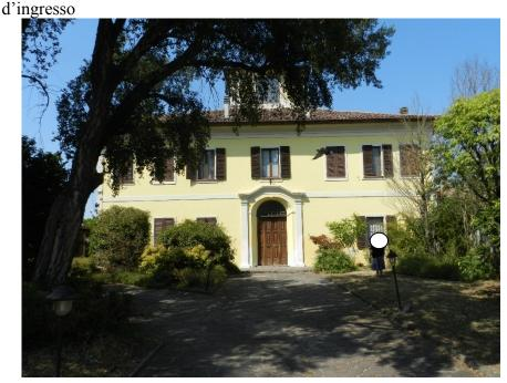
L'edificio principale risulta di vecchio impianto è realizzato in muratura tradizionale di mattoni pieni , solai misti , copertura a tetto con manto in coppi .Al suo interno troviamo un ampio appartamento ristrutturato in maniera signorile nel 1996 che attualmente veste in condizione
