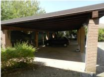
Realizzata con pilastri in mattoni faccia a vista e copertura a tetto ad una falda in legno con altezza utile interna di ml 2,20 max.
