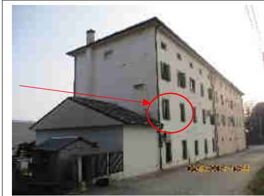
Foto n. 23: prospetto Nord-Ovest del fabbricato
