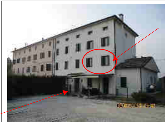
Foto n. 21: prospetto Sud-Est del fabbricato
