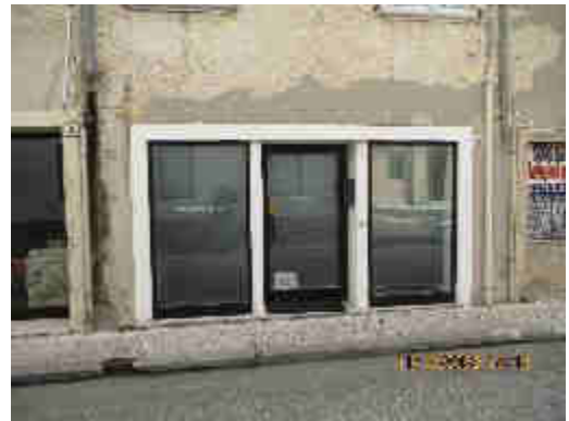
Foto n. 2: accesso e vetrine da Via G. Lioni (prospetto Nord)
