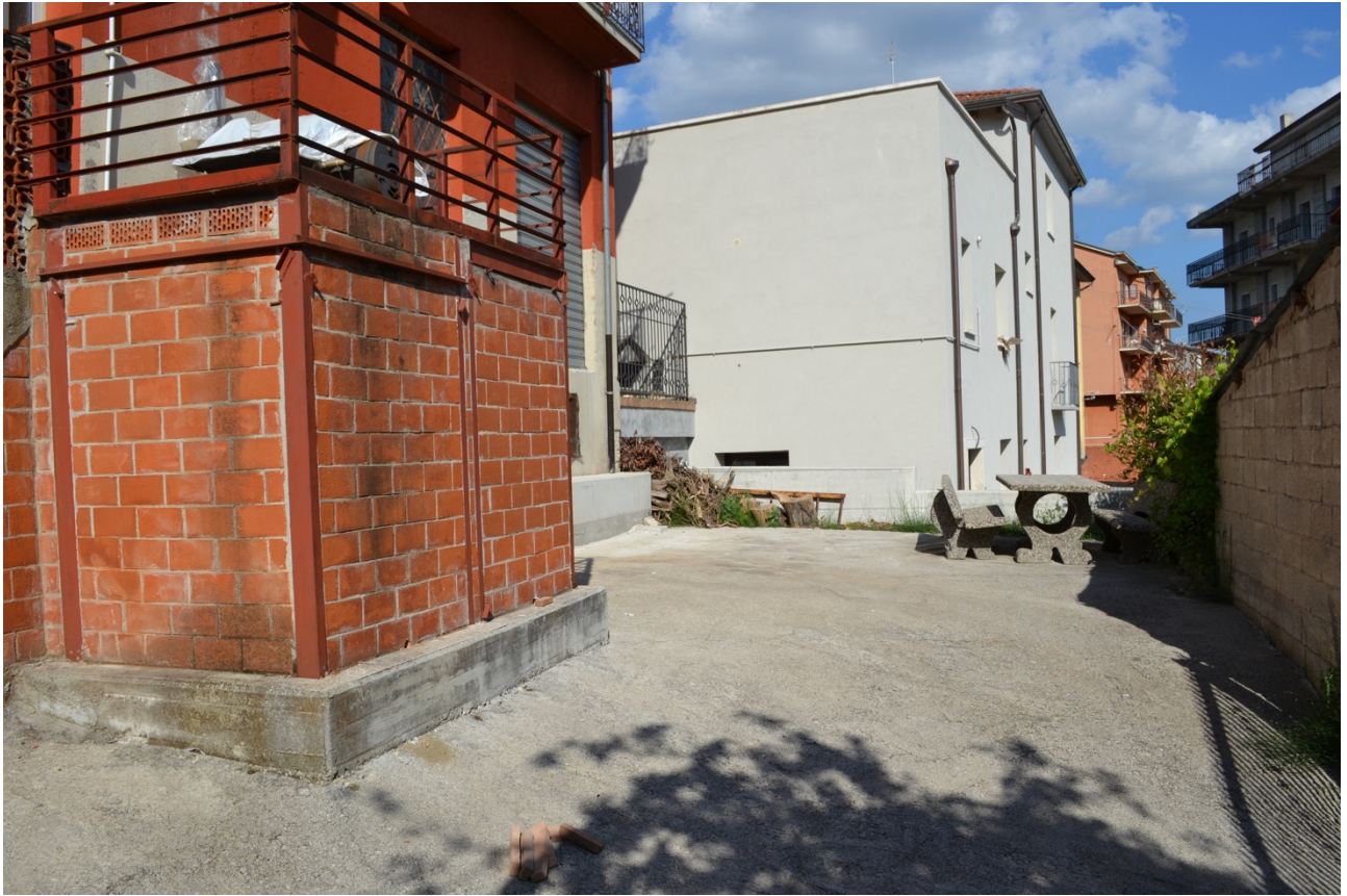
FOTO 11 - VISTA CORTE COMUNE (RETRO)
