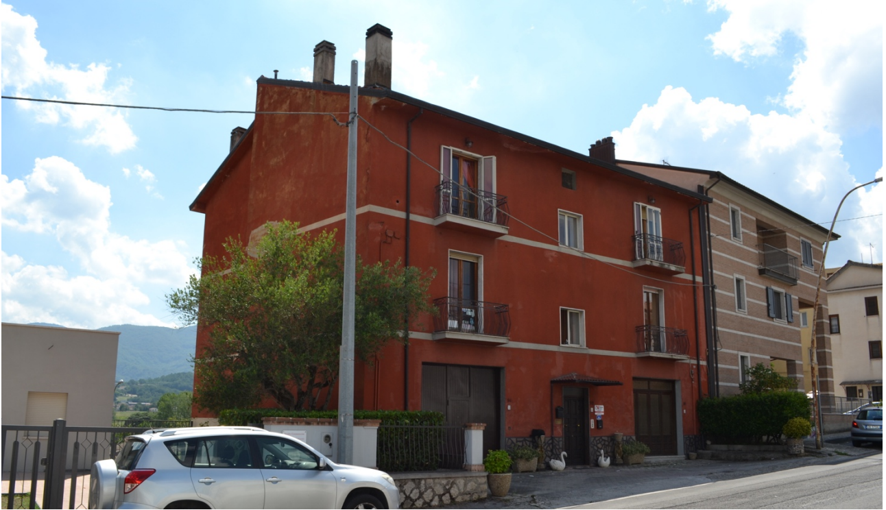
FOTO 1 - PROSPETTO DA VIA MARCONI
