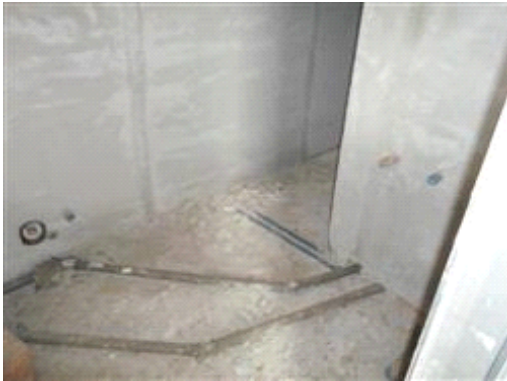
interno con impianti
