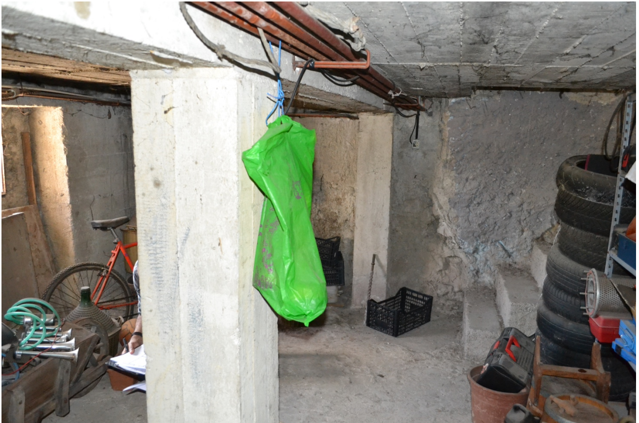
FOTO 7 - SCALE VANO TECNICO INTERRATO
