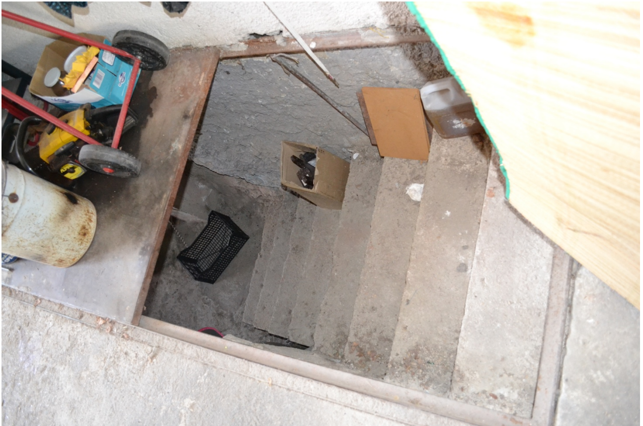
FOTO 5 - SCALE VANO TECNICO INTERRATO
