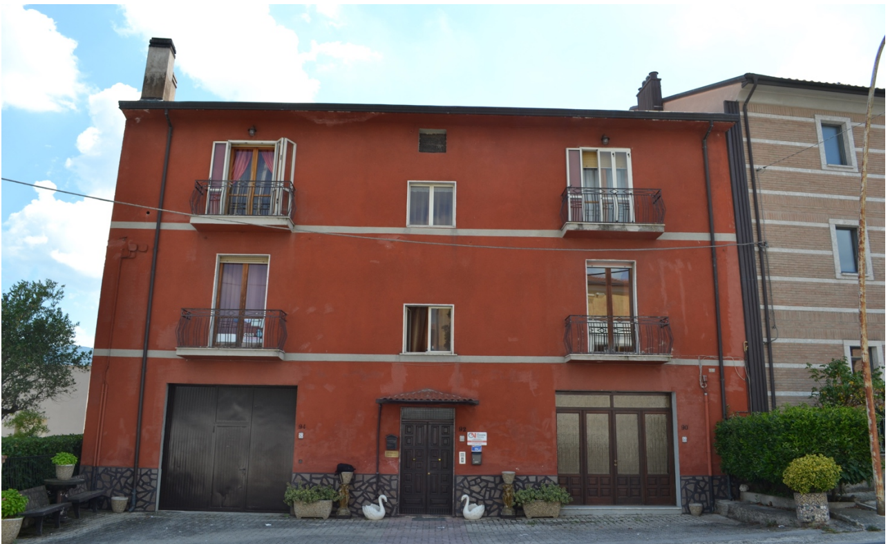
FOTO 2 - PROSPETTO DA VIA MARCONI
