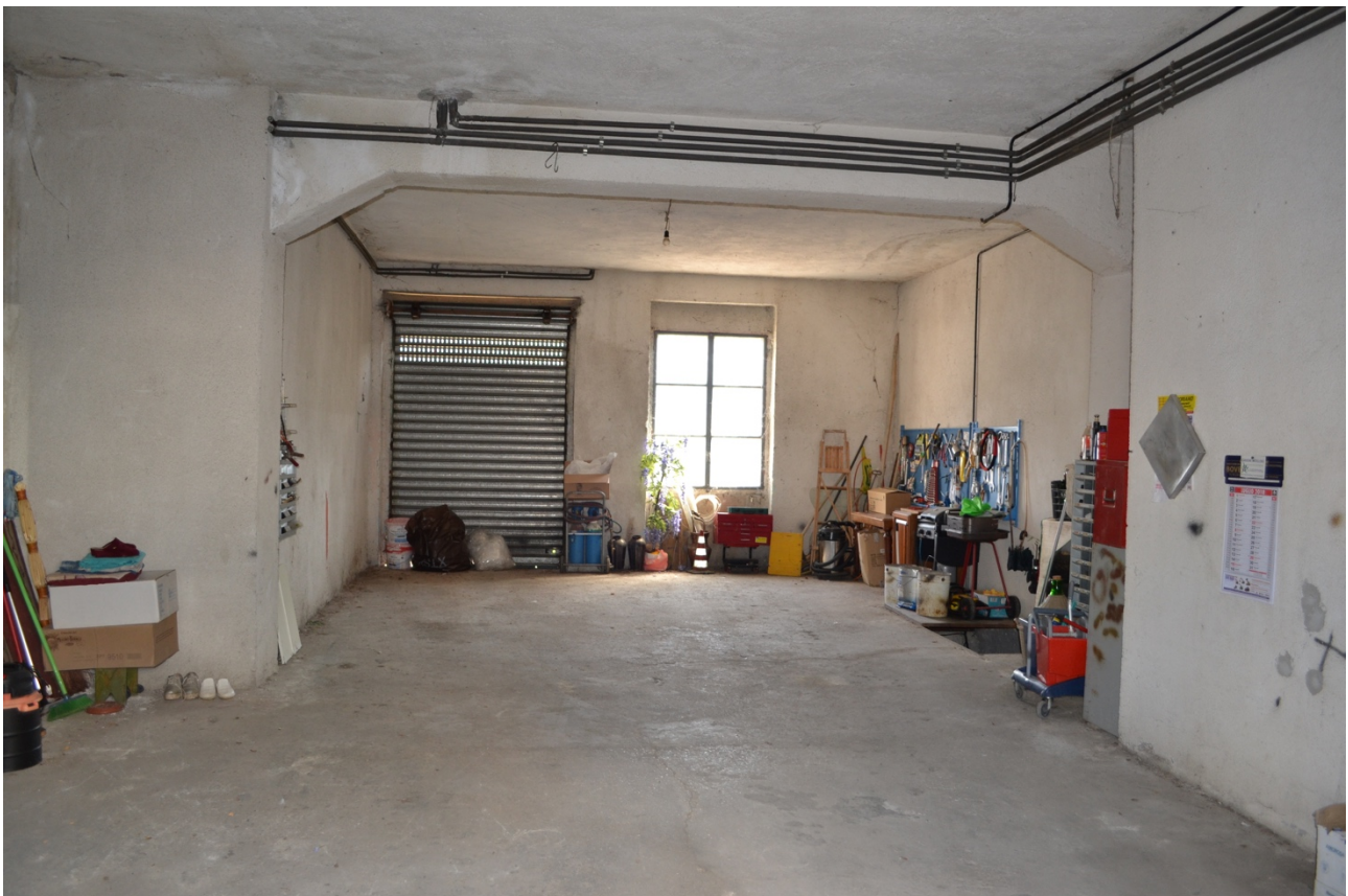
FOTO 4- INTERNO AUTORIMESSA - PROSPETTO VERSO CORTE (RETRO)
