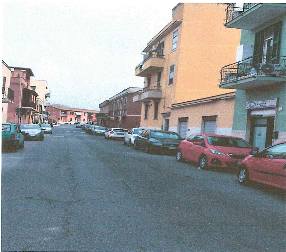
FOTO 1- via dell'Amba Aradam - a destra l'edificio part.lla 169
