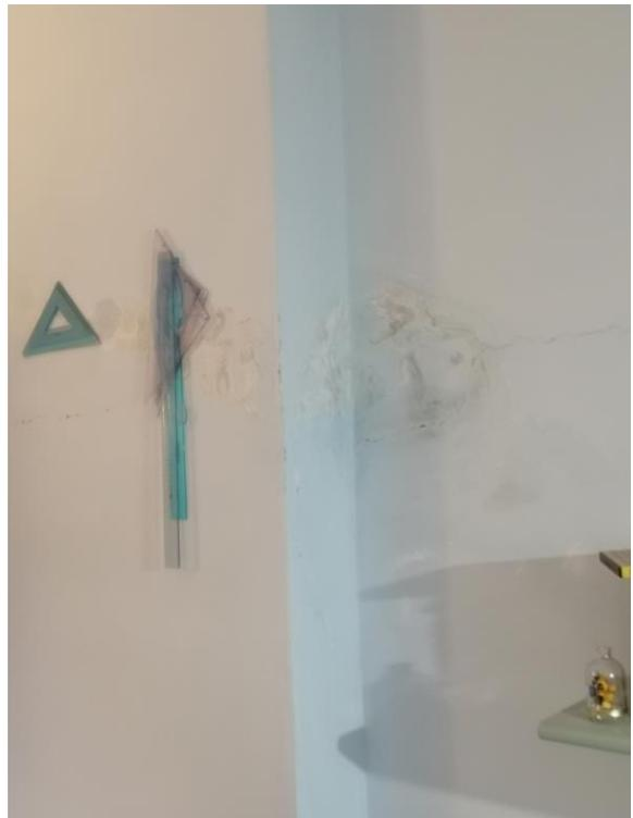
Foto 92 Particolare umidità e infiltrazioni sulle pareti
