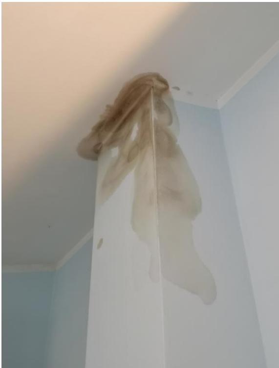
Foto 91 Particolare umidità e infiltrazioni su pareti e soffitti
