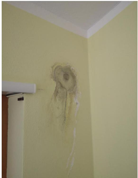
Foto 80 Particolare umidità e infiltrazioni sulle pareti
