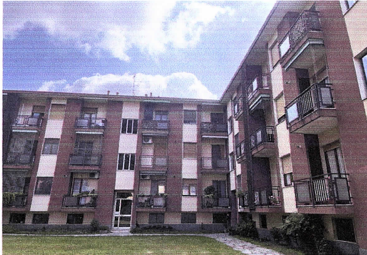
1. Ripresa fotografica esterna dell'immobile condominiale da Via Ugo Foscolo
