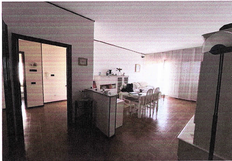
9. Ripresa fotografica del soggiorno (dove è visibile la porzione di tramezzatura demolita / abbassata a cm 100)
