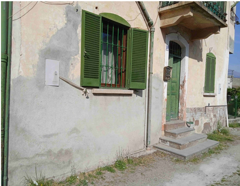
FOTO N.3 – Prospetto Est con portone di accesso al vano scala comune
