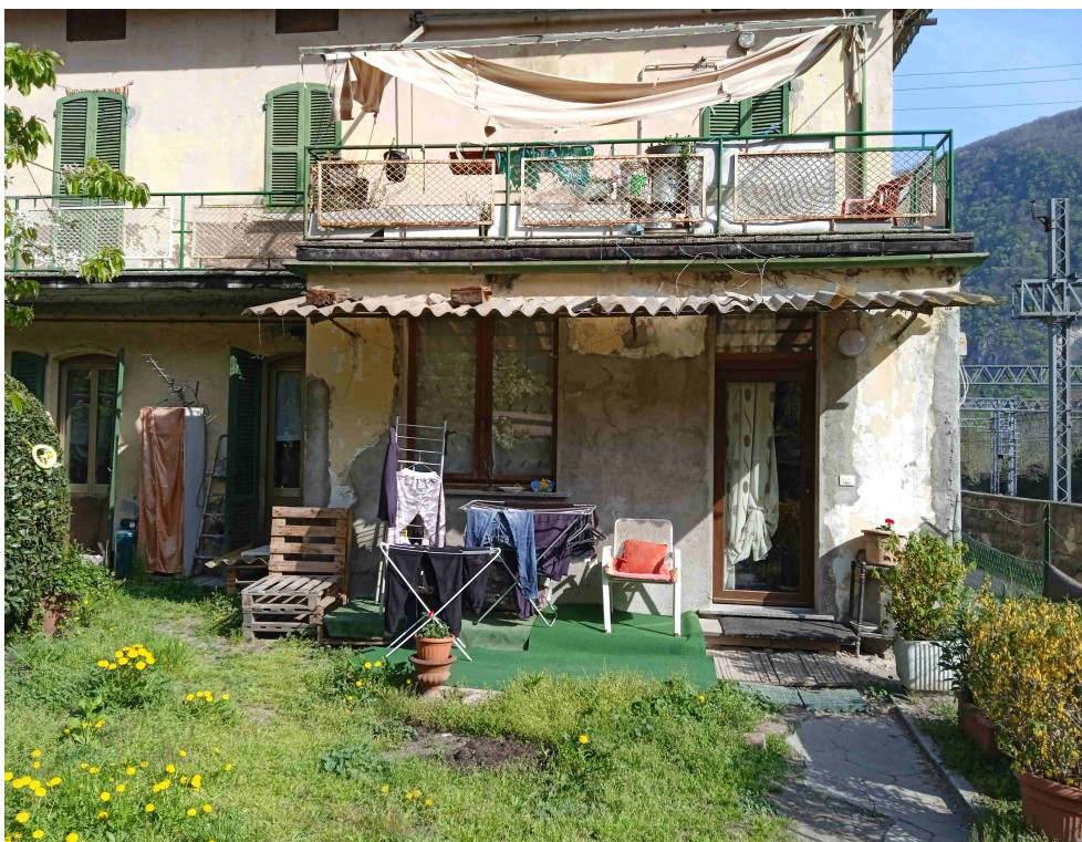
FOTO N.2 –Prospetto Sud con ingresso da area pertinenziale
