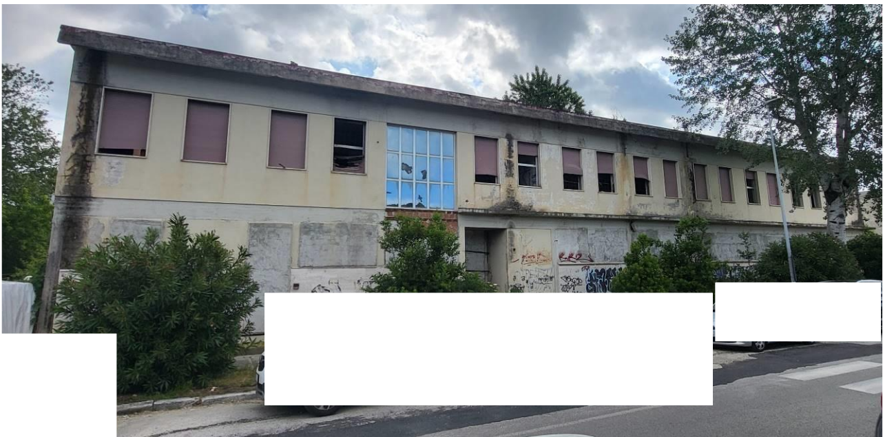
Sopra foto prospetto lato Via Aurelia
