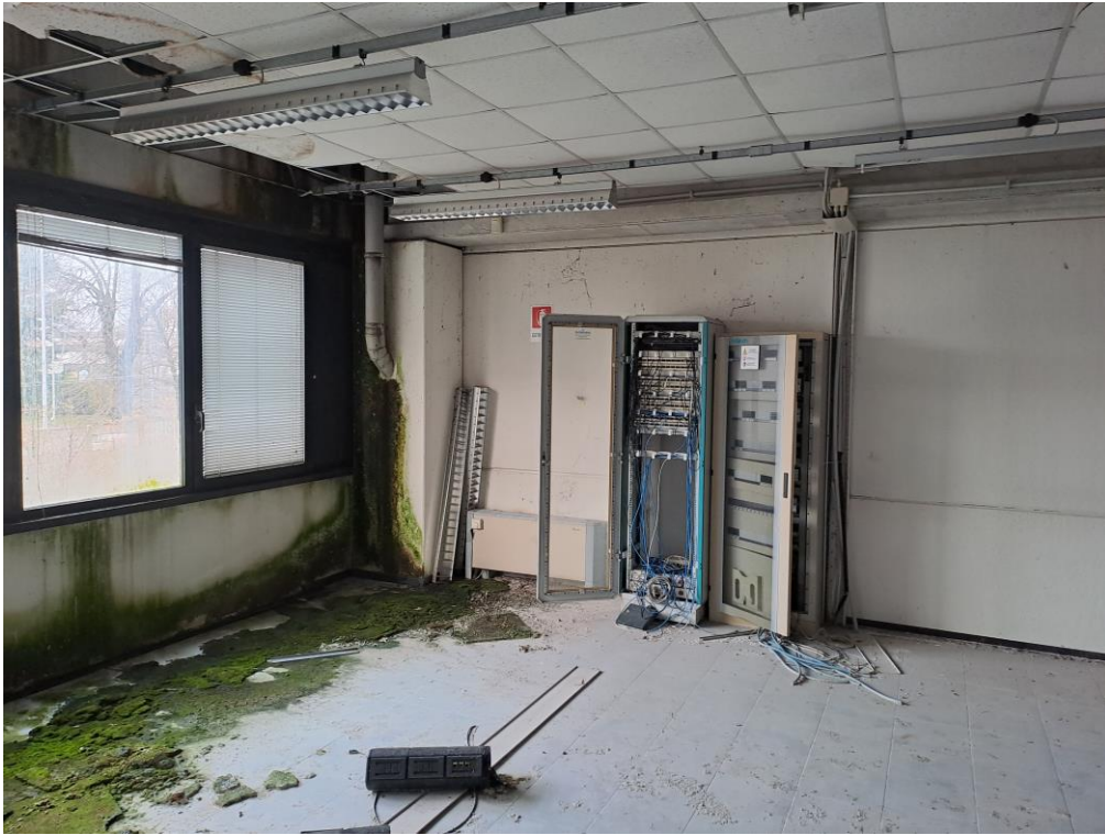
FOTO N°15. - visione interna fabbricati
