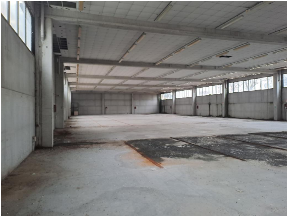
FOTO N°10. - visione interna fabbricati
