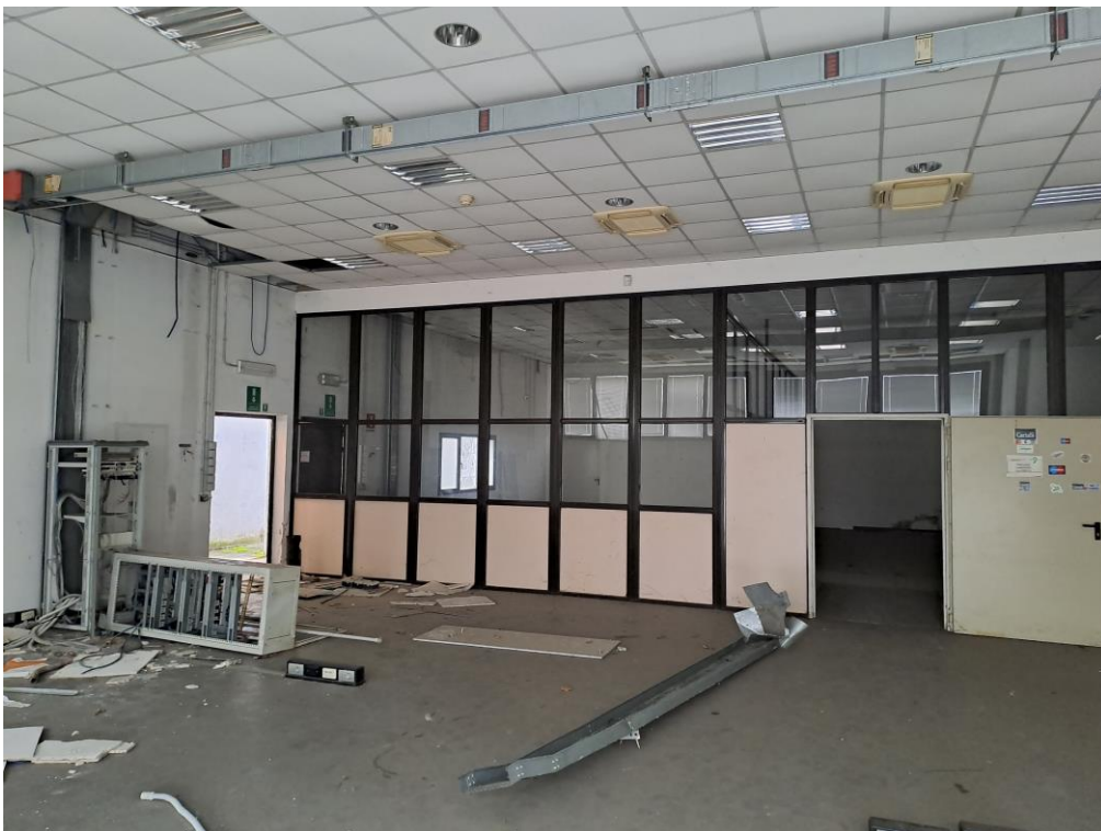
FOTO N°16. - visione interna fabbricati
