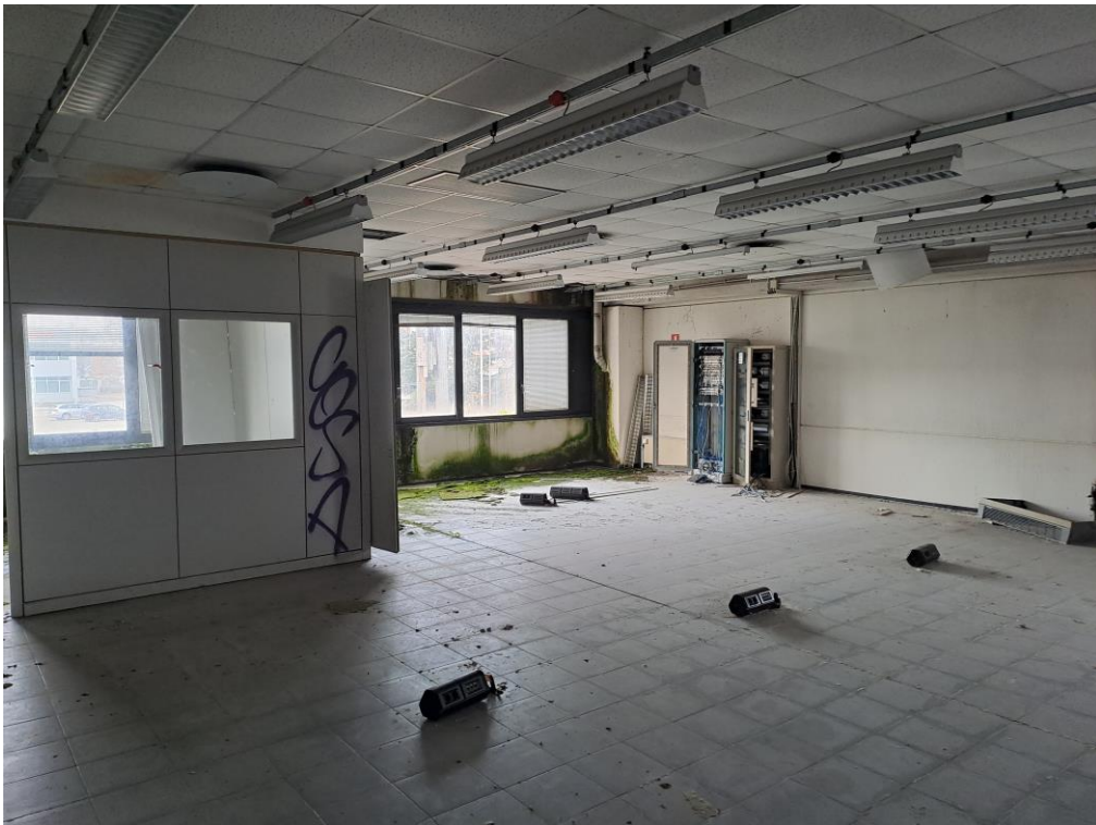
FOTO N°14. - visione interna fabbricati
