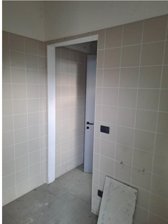
FOTO N°9. - visione interna fabbricati
