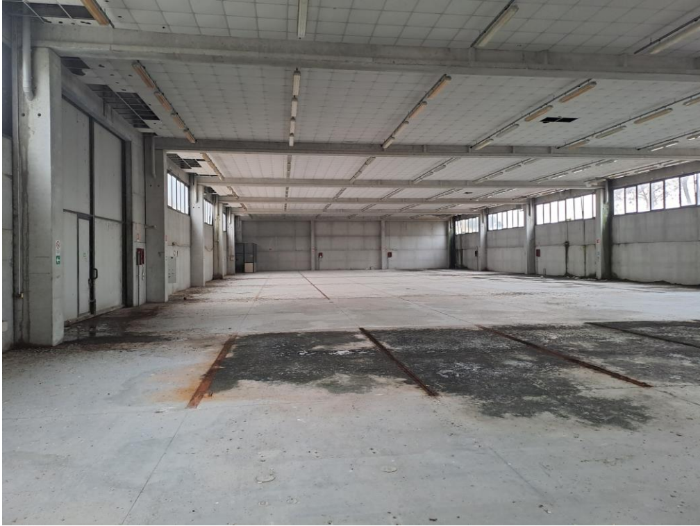
FOTO N°11. - visione interna fabbricati
