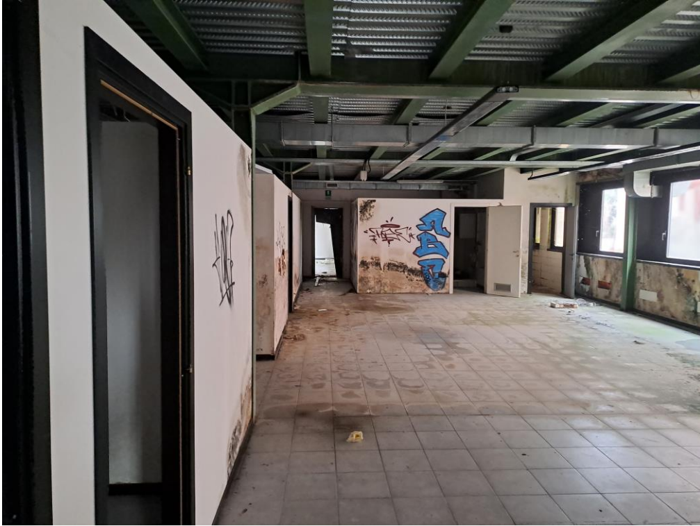
FOTO N°13. - visione interna fabbricati
