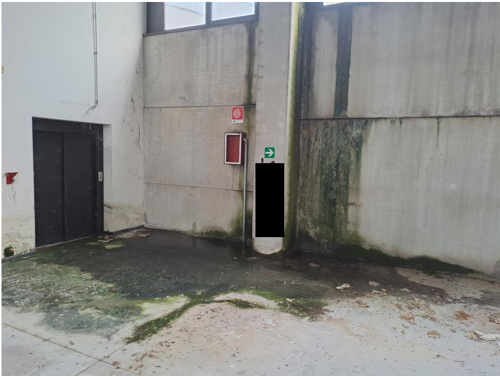
FOTO N°12. - visione interna fabbricati
