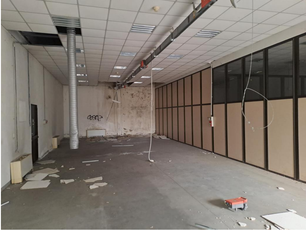
FOTO N°17. - visione interna fabbricati
