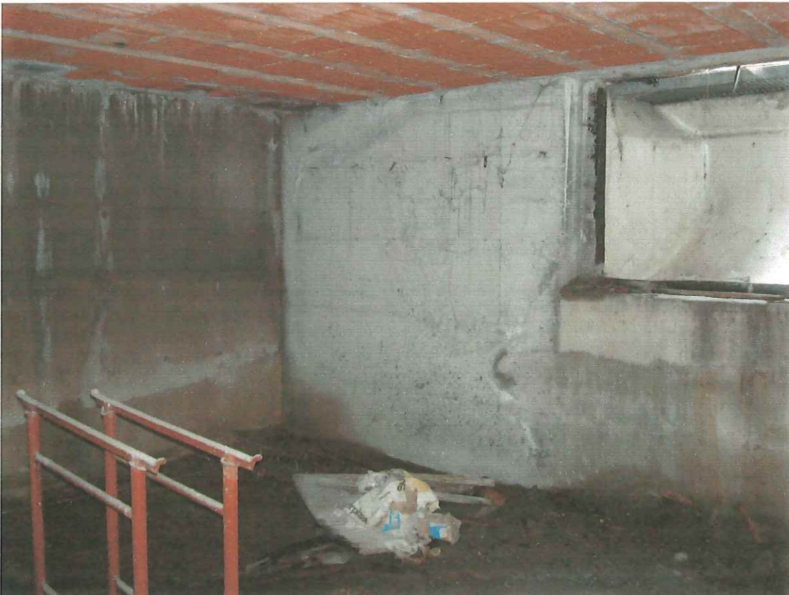
Piano seminterrato : locale ripostiglio
