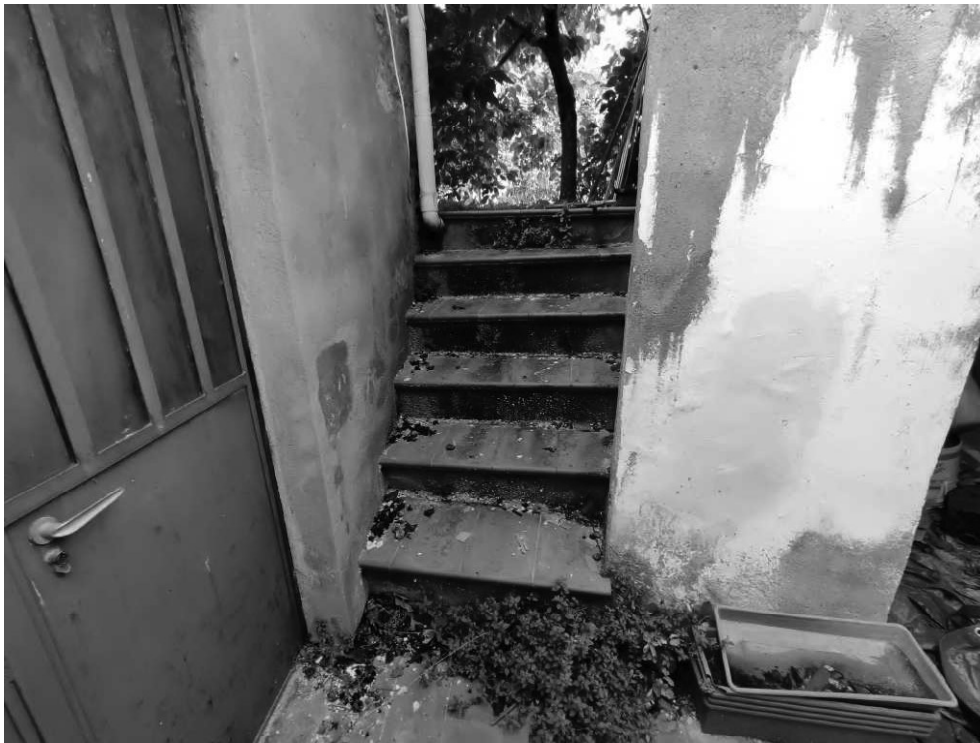
Foto 28 – Dettaglio scale di collegamento resede
