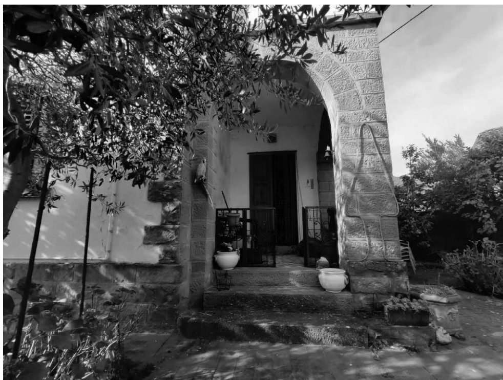
Foto 7 – Vista loggia esterna
