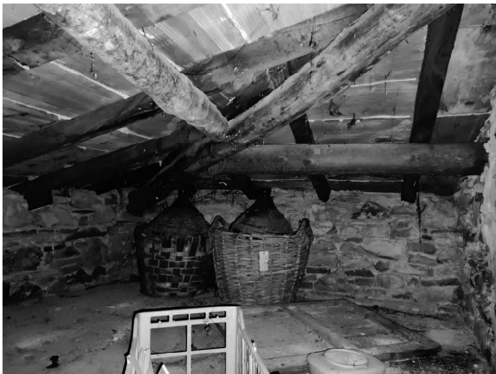
Foto 25 – Soffitta piano secondo
