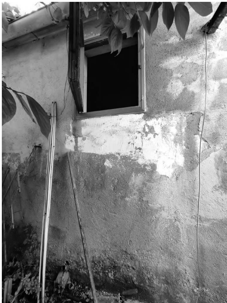
Foto 31 – Vista esterna BENE 2 – Deposito
