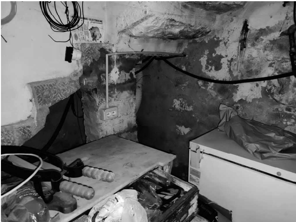
Foto 15 – Disimpegno piano seminterrato
