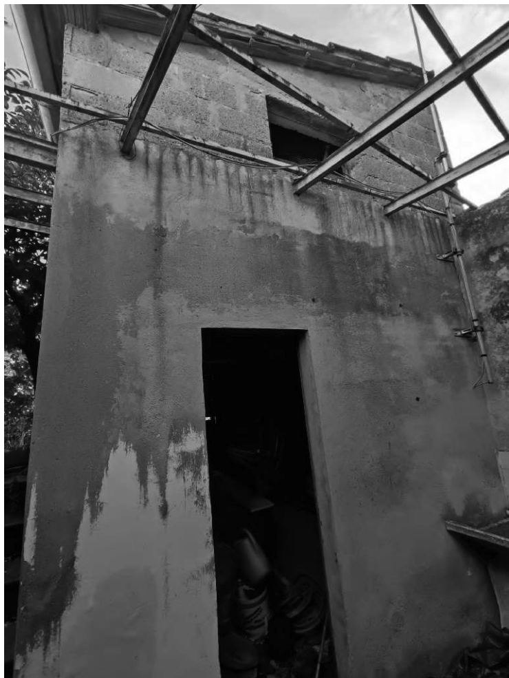
Foto 27 – Vista esterna BENE 2 – Deposito
