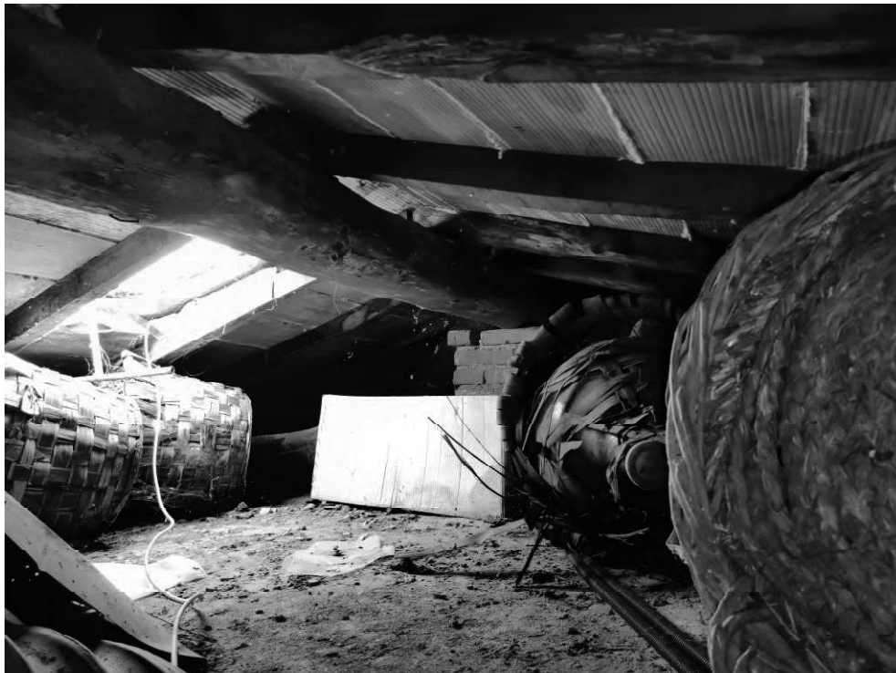
Foto 24 – Soffitta piano secondo
