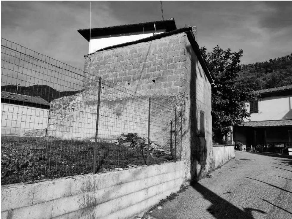
Foto 26 – Vista esterna BENE 2 - Deposito
