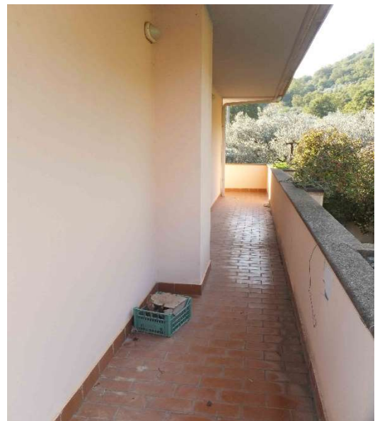
Foto 24, esterno P.1, balcone.
