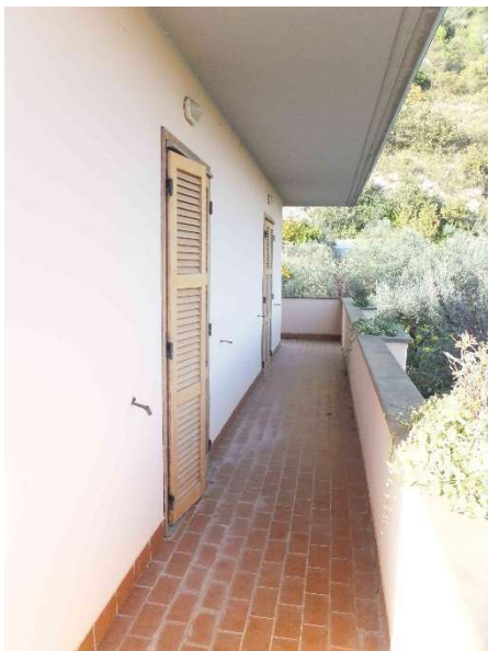
Foto 23, esterno P.1, balcone.
