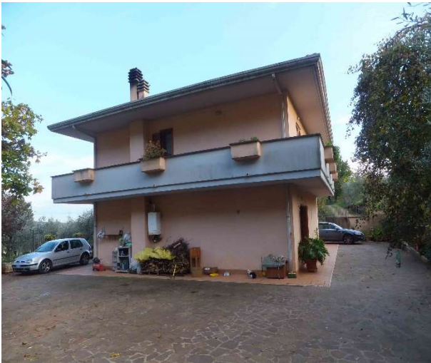
Foto 03, esterno fabbricato, lato est.
