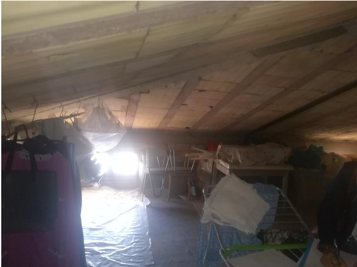
Sub. 21 - PIANO TERZO SOTTOTETTO : PORZIONE DI SOFFITTA
