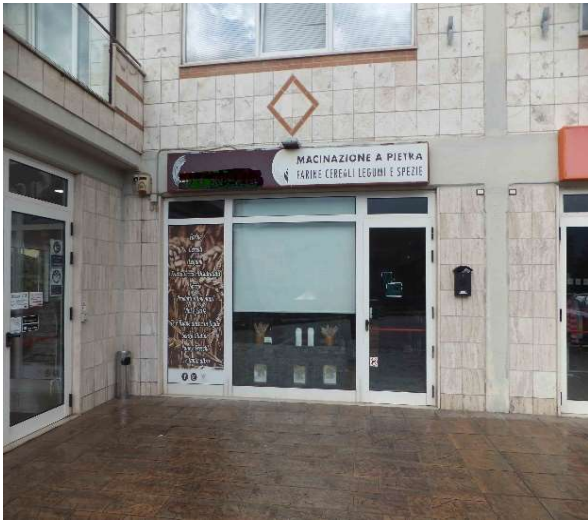
E.I. 133/2023. Foto 01, esterno locali commerciali.
