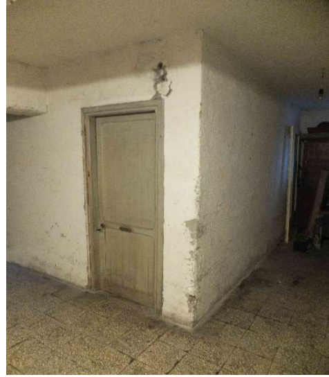
Foto 20, P.T. interno, corridoio e cantina.
