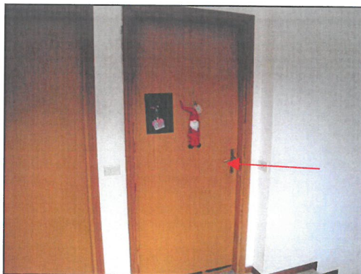
FOTO 10 VISTA DELL'INGRESSO ALL'U.I. ABITATIVA OGGETTO DI PROCEDURA ESECUTIVA MAPPALE 514 SUB. 3 (INDICATO CON LA FRECCIA ROSSA).
