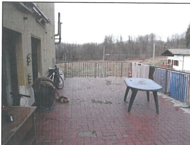
FOTO 19 U.I. MAPPALE 514 SUB. 3. ALTRA VISTA DEL TERRAZZO COLLEGATO ALLA CUCINA E AL SOGGIORNO.
