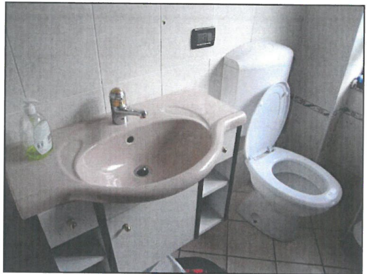
FOTO 25 U.I. MAPPALE 514 SUB. 3. ALTRA VISTA DEL BAGNO DELLA ZONA GIORNO.
