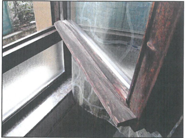
FOTO 28 U.I. MAPPALE 514 SUB. 3. VISTA PARTICOLARE SERRAMENTO BAGNO DELLE FOTO PRECEDENTI.
