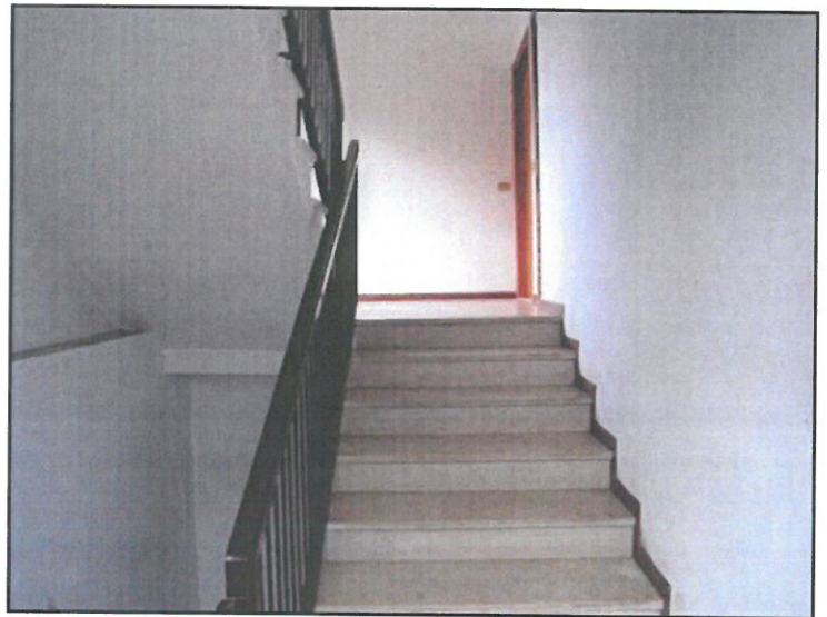
FOTO 8 VISTA DEL VANO SCALA CONDOMINIALE.
