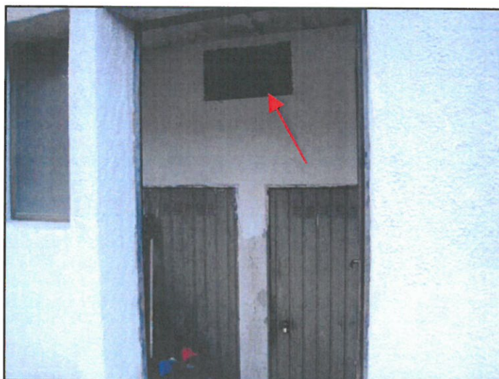
FOTO 45 VISTA INGRESSI ALLE CANTINE OGGETTO DI PROCEDURA.
