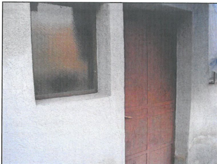
FOTO 43 VISTA RIPRESA VERSO INGRESSO AL DISIMPEGNO CANTINE.
