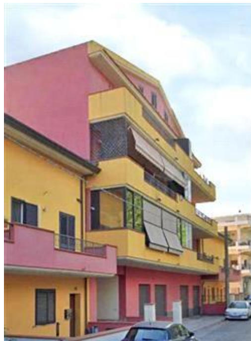
Condominio "Garibaldi" - prospetto su via Garibaldi
