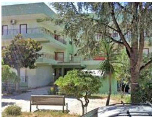
vista fabbricato da Piazza Nenni
