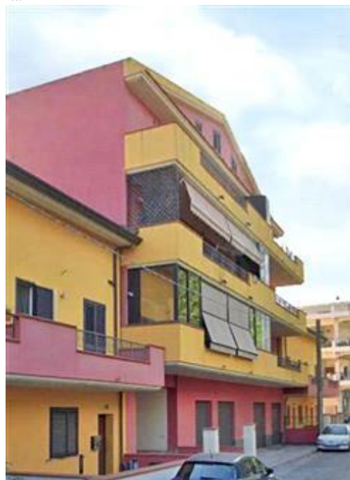
Condominio "Garibaldi" - prospetto su via Garibaldi
