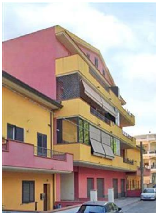
Condominio "Garibaldi" - prospetto su via Garibaldi
