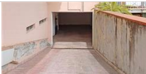
Rampa di accesso al piano cantinato
