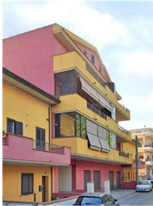
Condominio "Garibaldi" - prospetto su via Garibaldi
