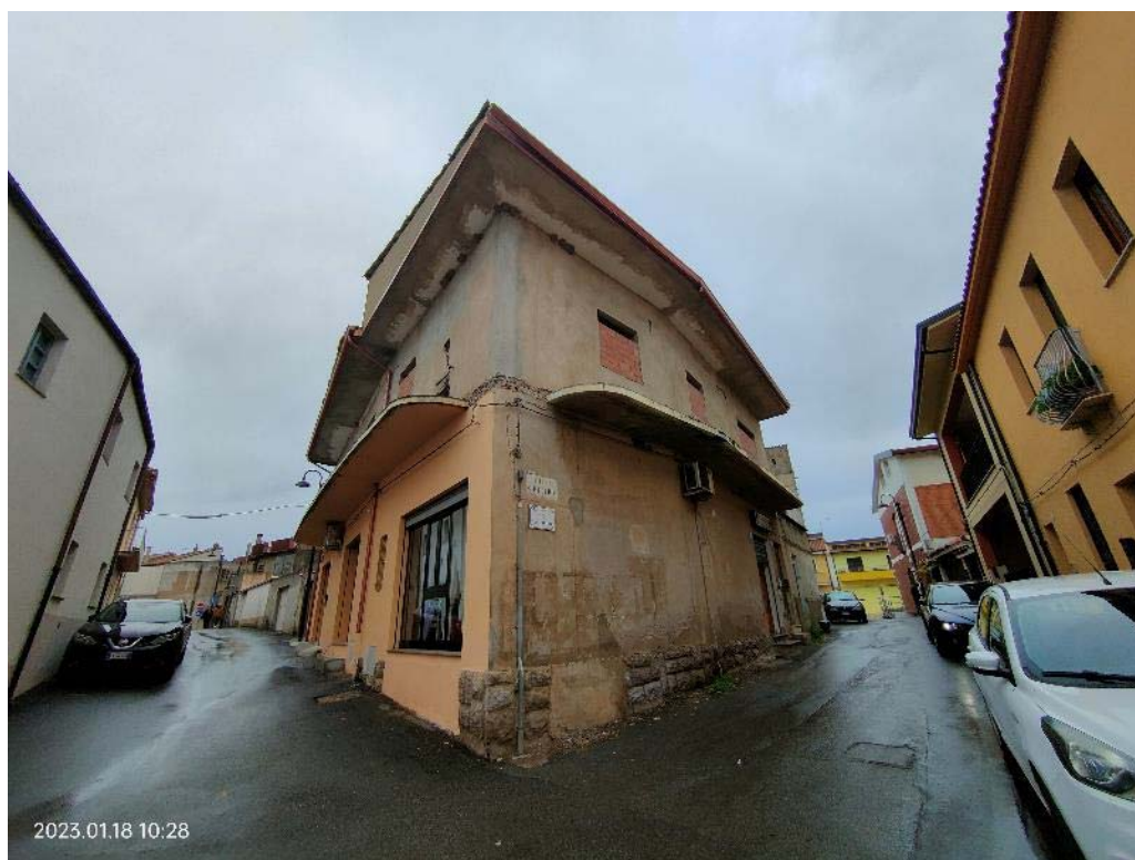
Foto 2 - Vista di insieme Via Centrale Angolo via San Pietro
