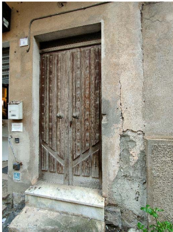
Foto 6 – Portoncino di accesso su Via San Pietro
