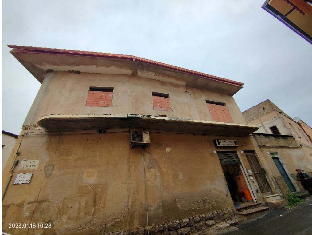
Foto 3 - Vista dell'ingresso esterno su Via San Pietro
