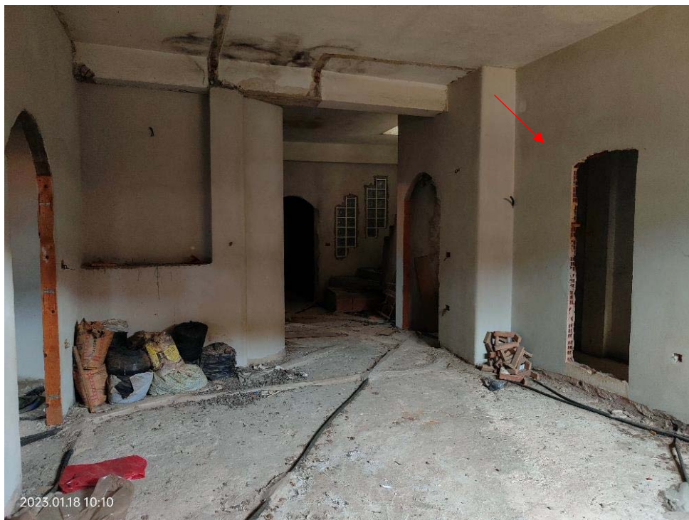
Varco di accesso al piano dal Vano scala
