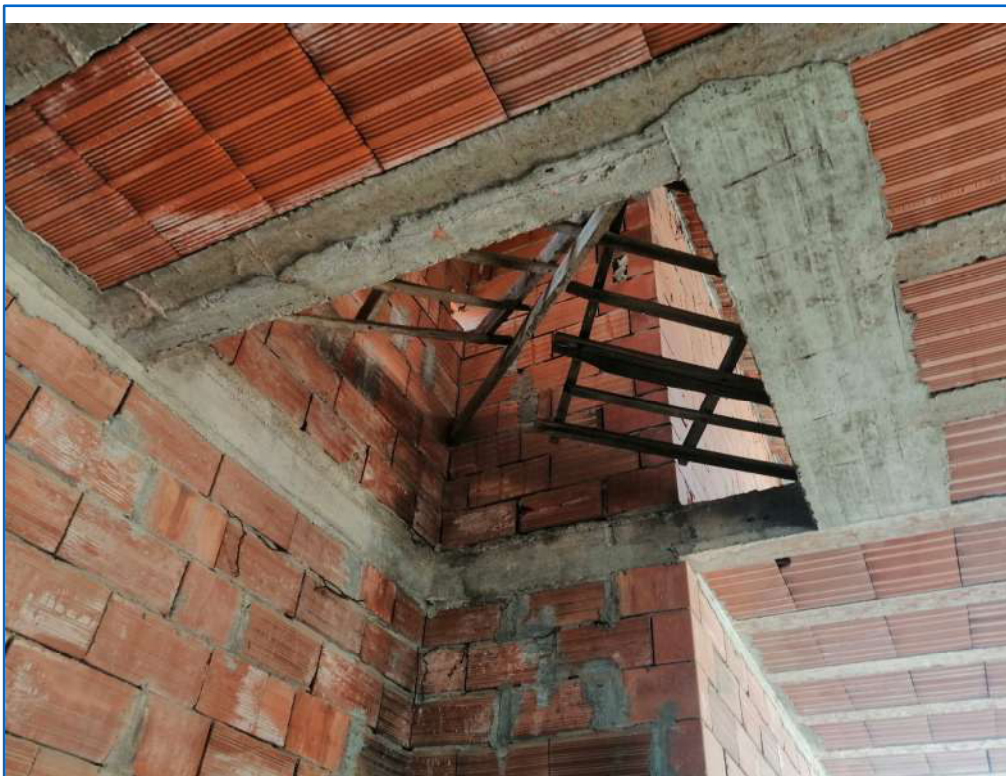
Foto 23 – Apertura sul solaio per accesso al sottotetto
