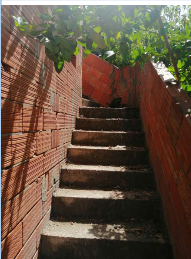
Foto 15 – Scale di accesso al piano primo
