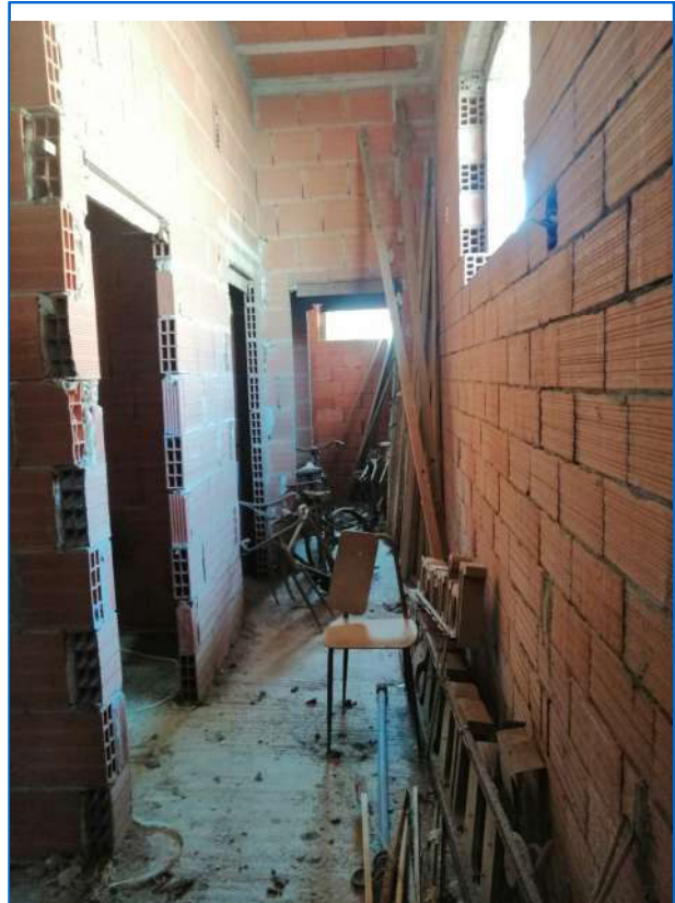
Foto 14 – Piano terra – zona servizi
