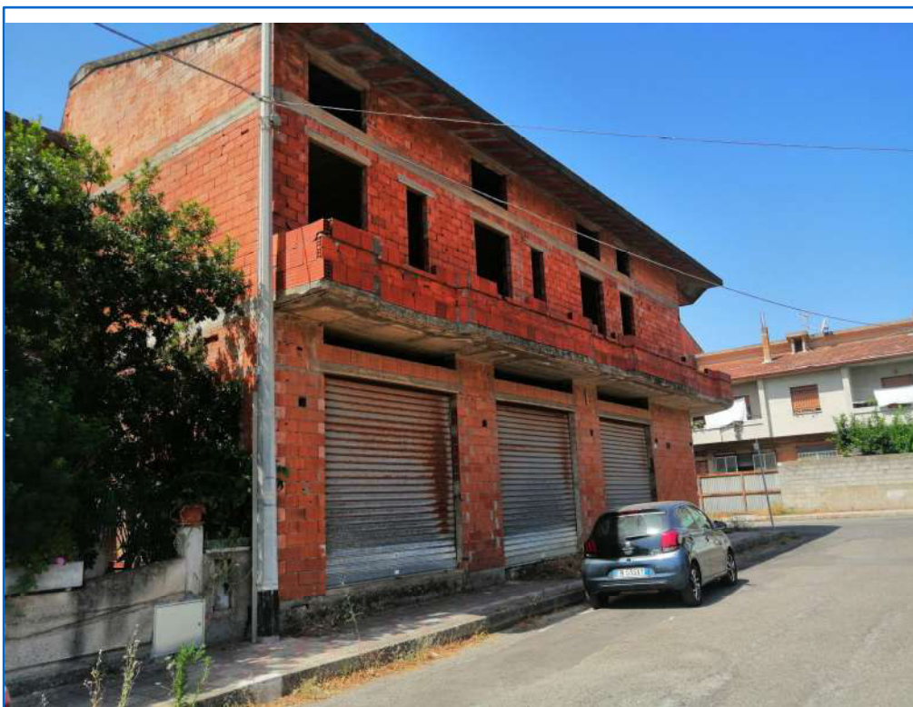
Foto 2 – Vista del fabbricato dalla via Dozza
