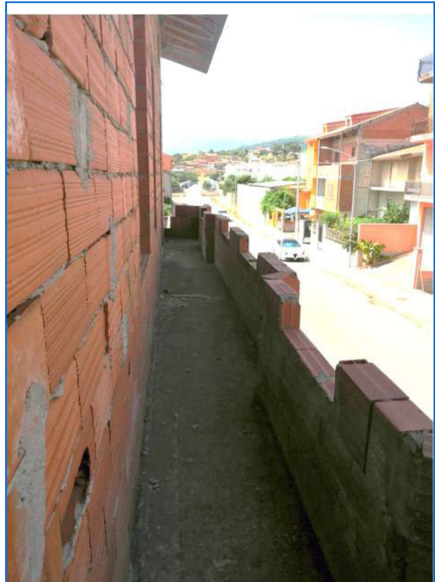
Foto 22 – Balconi primo piano
