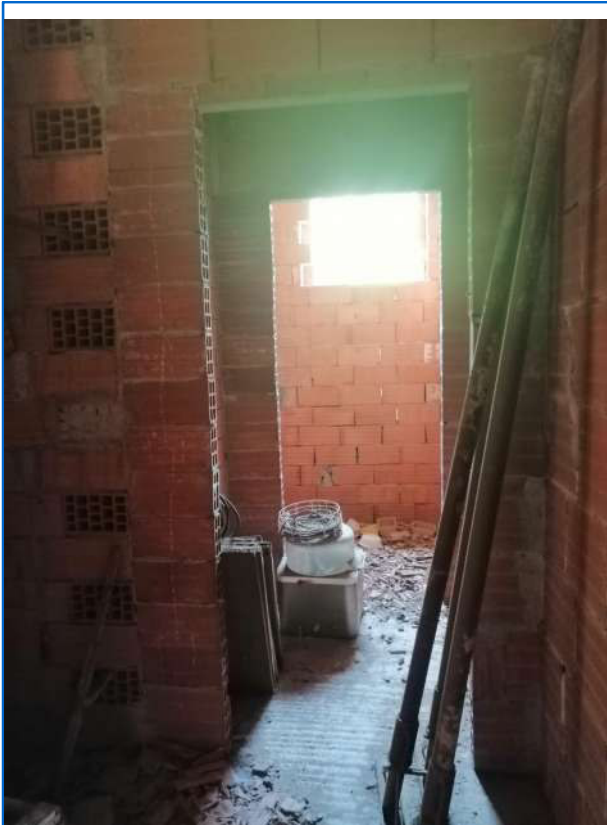
Foto 13 – Piano terra – zona servizi
