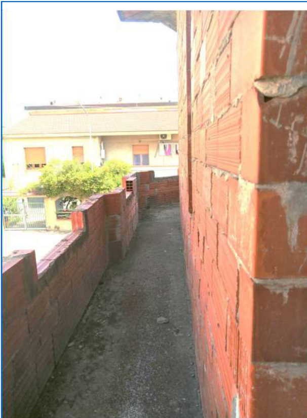
Foto 21 – Balconi primo piano
