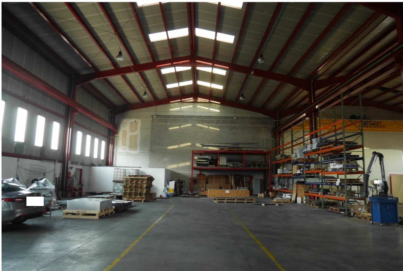
FOTO 14 - Porzione ad uso capannone industriale.
