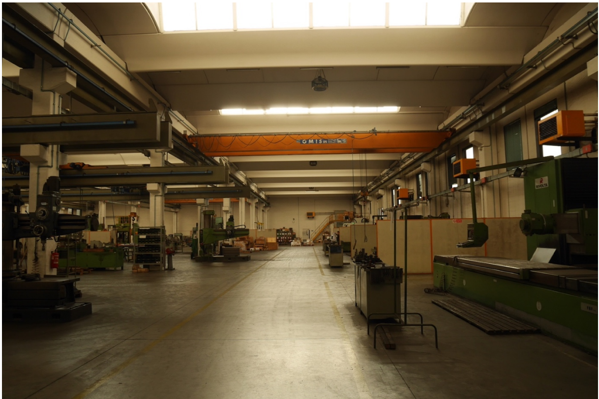
FOTO 4 - La porzione ad uso capannone.
