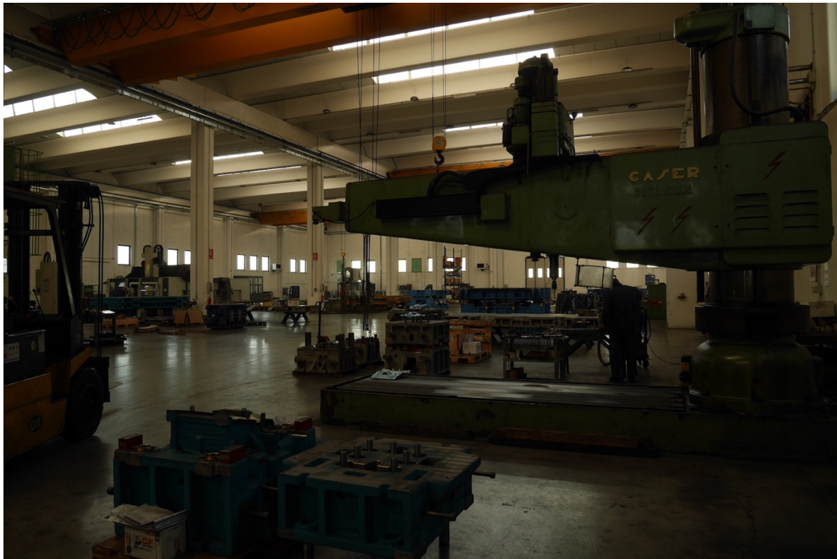
FOTO 5 - La porzione ad uso capannone.
