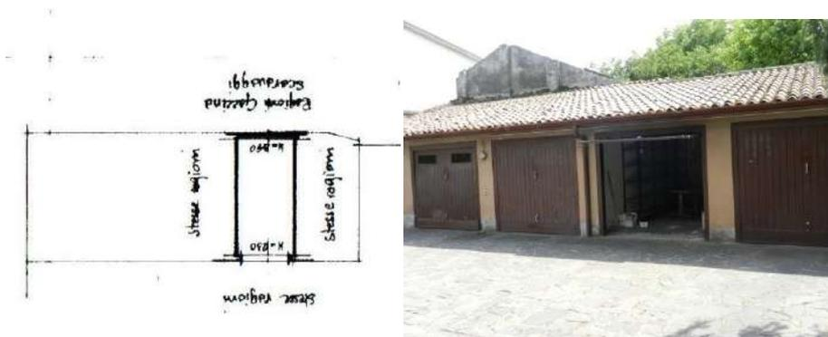
Questo è in struttura muraria tradizionale con portoni d'accesso tipo basculante . Il box è servito da impianto elettrico ed ha pavimento in battuto di calcestruzzo .
