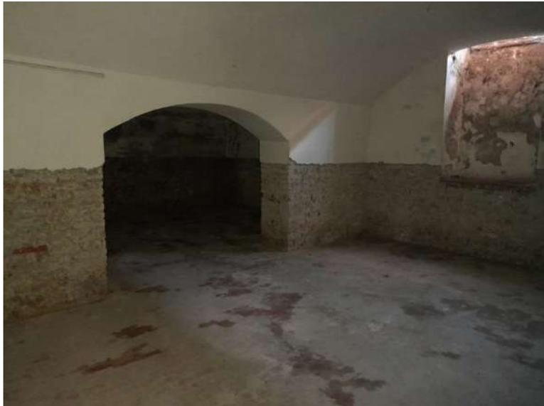
Il solaio interpiano è a volta con altezza interna variabile da ml 2,10 a ml 2,80 circa ; i pavimenti sono in clincher e gres .
