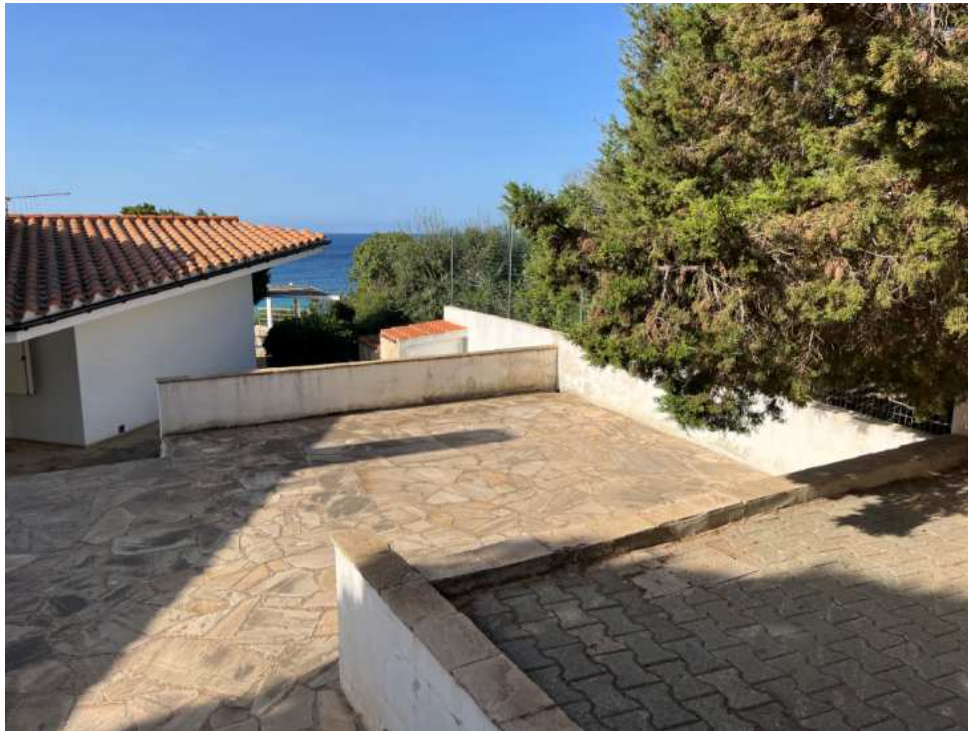
Foto 3: area esterna di accesso al fabbricato (21/10/2022)
