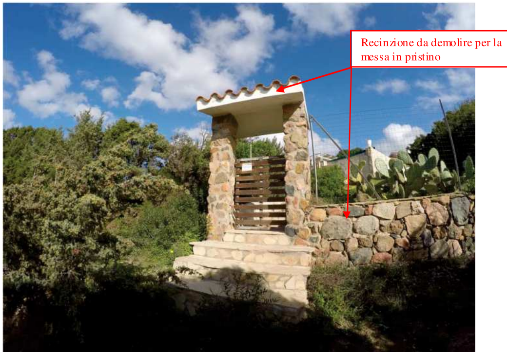
Tratto di recinzione oggetto di messa in pristino (anno 2017)
