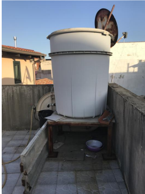
Imm. 38: Particolare della riserva idrica
