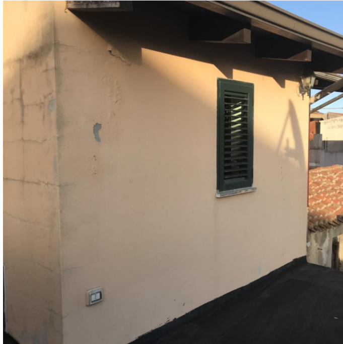
Imm. 40: Esterno del volume che ospita il bagno B2
