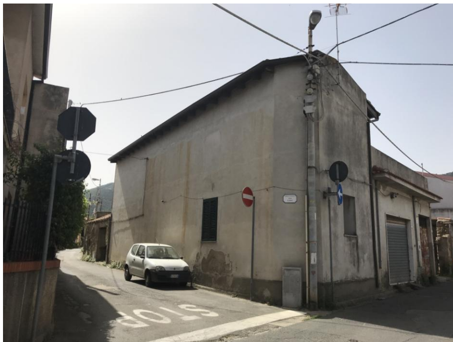
Imm. 2: Il fabbricato visto dall'incrocio tra la via della Croce e la via Casti
