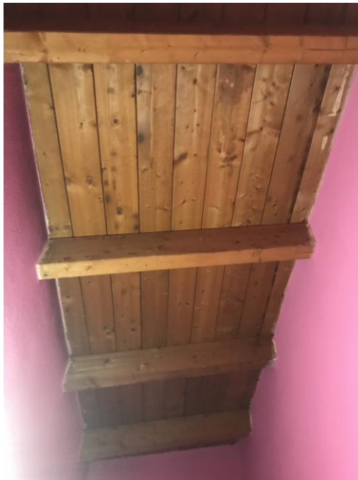
Imm. 35: Particolare della copertura in legno
