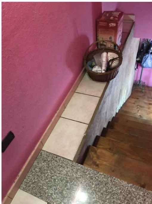
Imm. 26: Particolare dal pianerottolo di arrivo al piano primo
