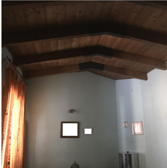
Imm. 34: Particolare della copertura in legno
