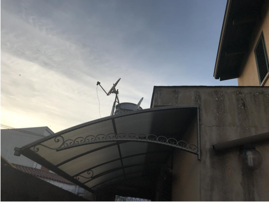
Imm. 15: Pensilina di protezione dalla pioggia della porta di ingresso all'unità immobiliare
