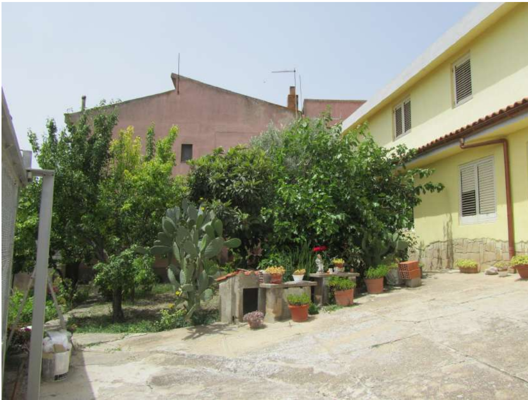
Foto n°5: Prospetto principale e cortile/giardino
