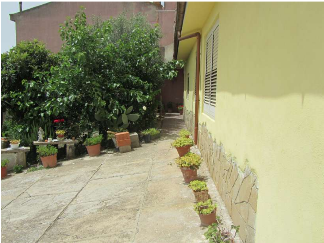
Foto n°6: Prospetto principale e cortile/giardino
