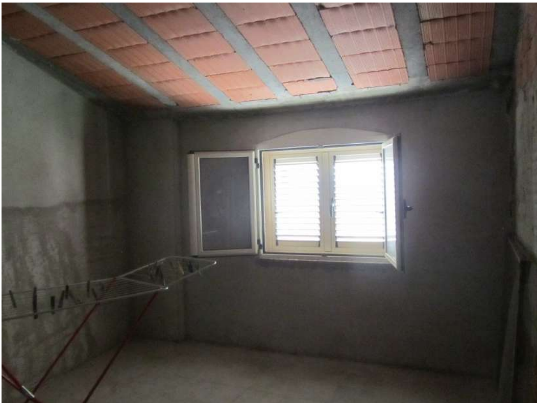
Foto n°32: Sgombero (ex veranda aperta)
