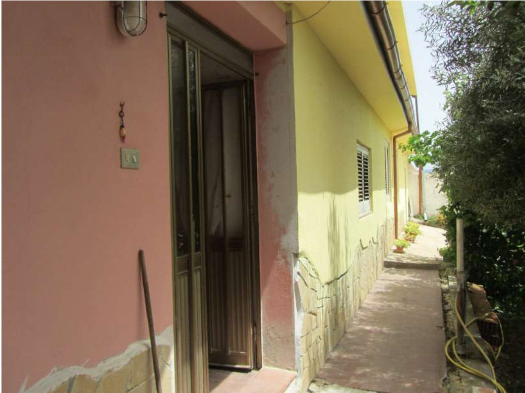
Foto n°7: Ingresso al fabbricato
