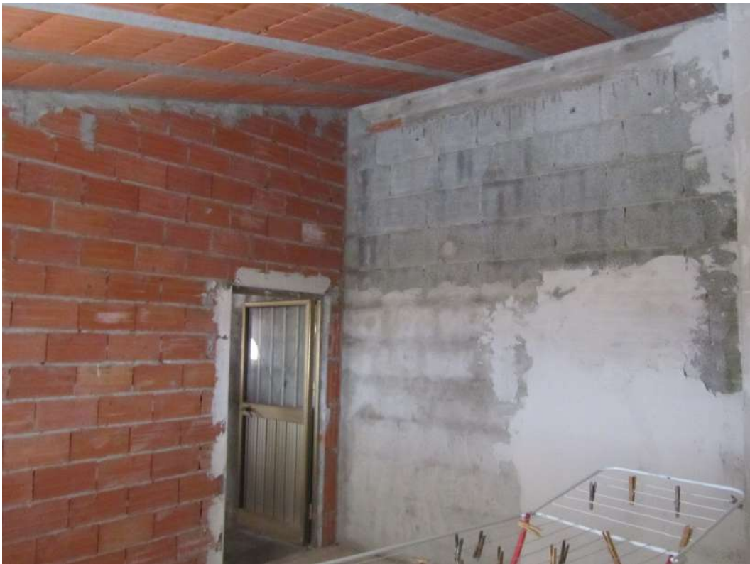
Foto n°31: Sgombero (ex veranda aperta)
