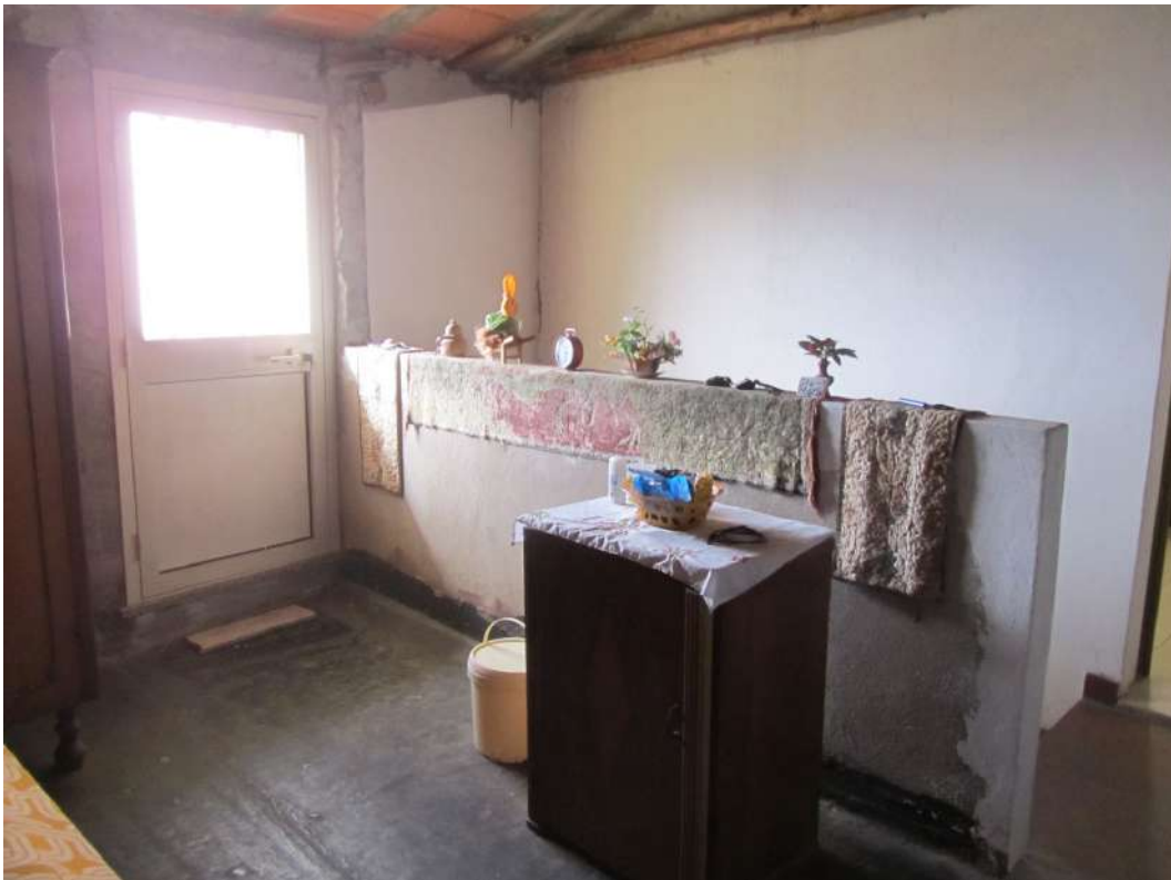
Foto n°33: Portafinestra per uscita al balcone
