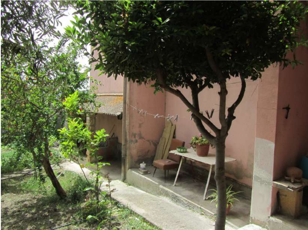
Foto n°37: Cortile (sotto il balcone) e tettoia
