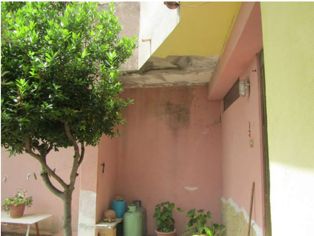
Foto n°36: Cortile (sotto il balcone)
