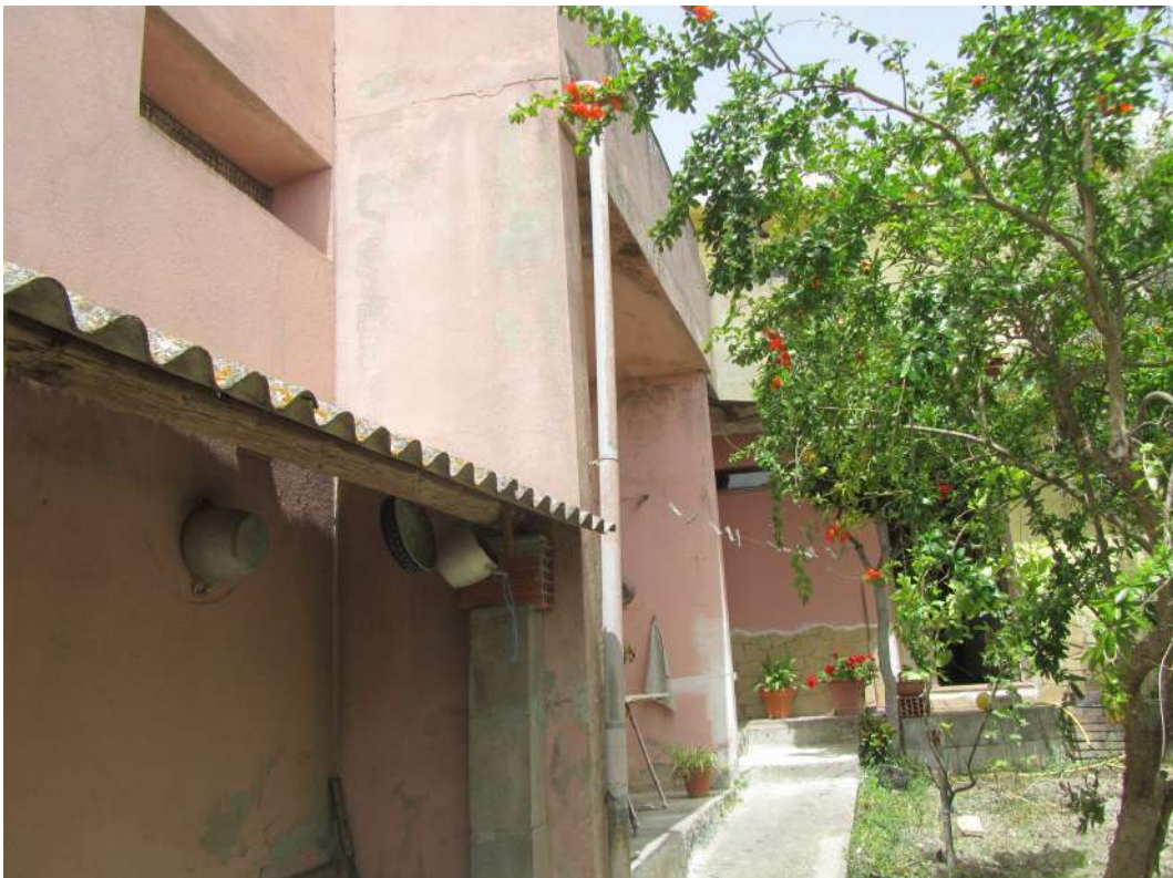
Foto n°38: Cortile (sotto il balcone) e tettoia
