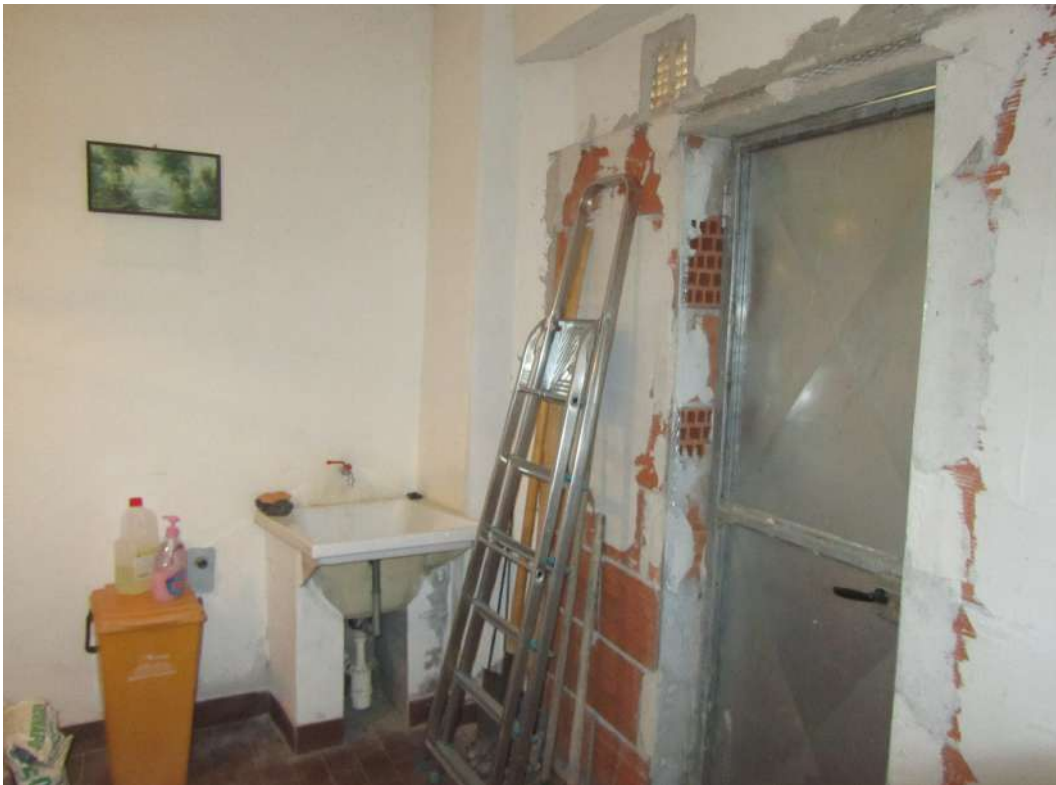
Foto n°23: Sgombero con camino (ex legnaia)
