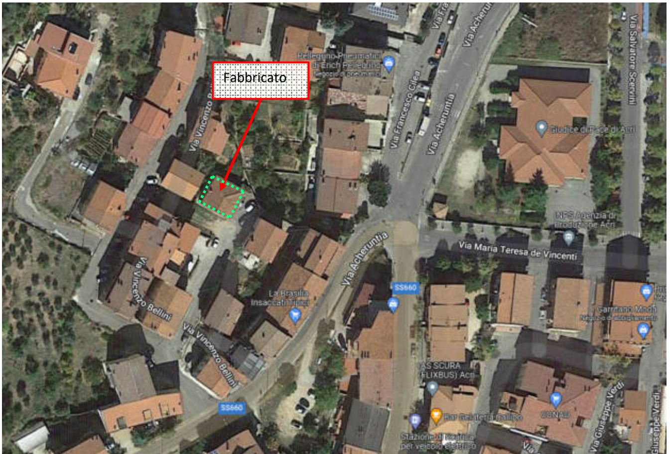
Foto n°1:– Vista aerea del fabbricato in catasto urbano del Comune di Acri (CS), fg. n°85, p.lla n°864;
