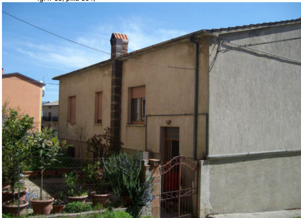
Foto n°4: –Vista dall’angolo Sud-Ovest del fabbricato in catasto urbano del Comune Acri (CS), fg. n°85, p.lla 864;
