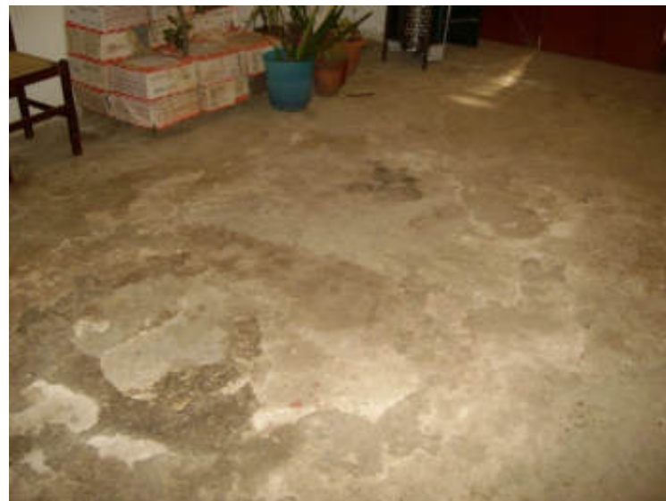
Foto n°18: sub n°3, Magazzino deposito (1); Pavimentazione
