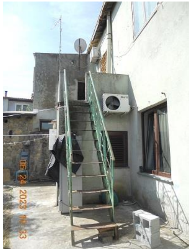
5 – scala in ferro di accesso al piano primo
