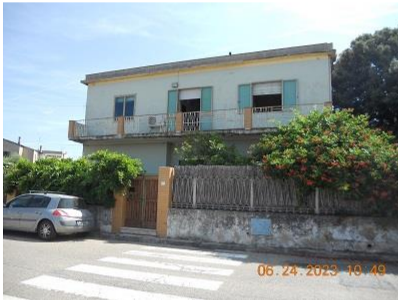
1 – vista fronte via Cagliari
