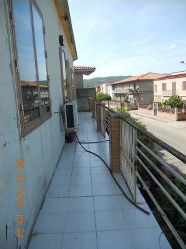
18 – balcone sul fronte strada
