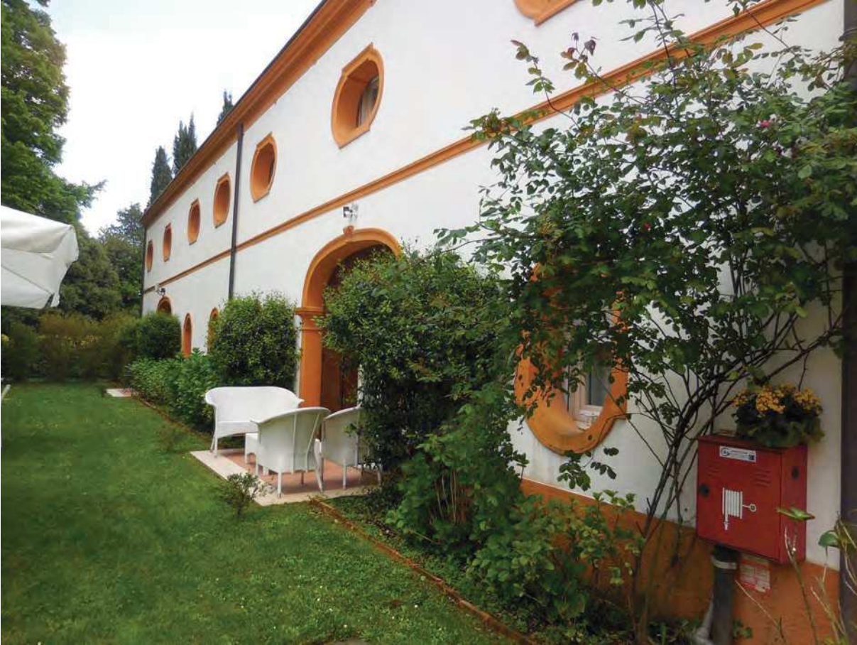
Foto 14 - vista esterna fabbricato dal parco fronte est
