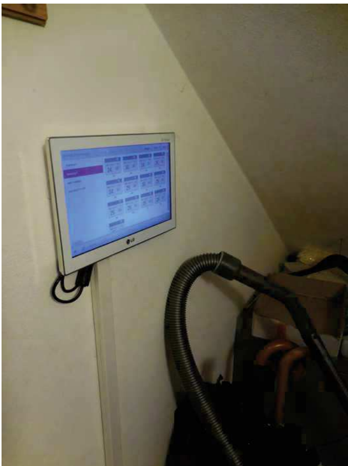
Foto 35 - piano terra – magazzino. sottoscala
