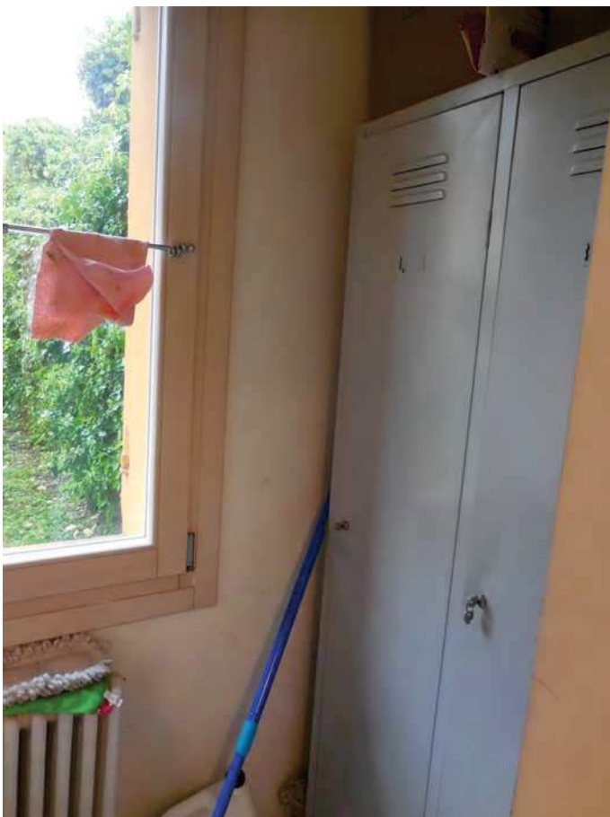
Foto 61 - piano terra – spogliatoio personale
