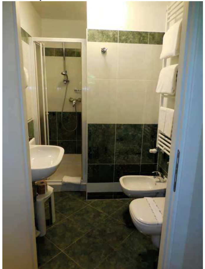
Foto 58 - piano terra – camera n. 07- bagno
