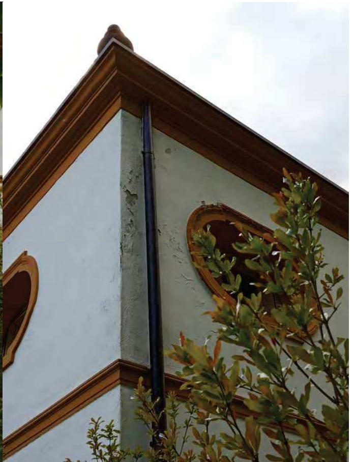
Foto 13 - vista esterna del fabbricato dal parco particolare fronte nord-est
