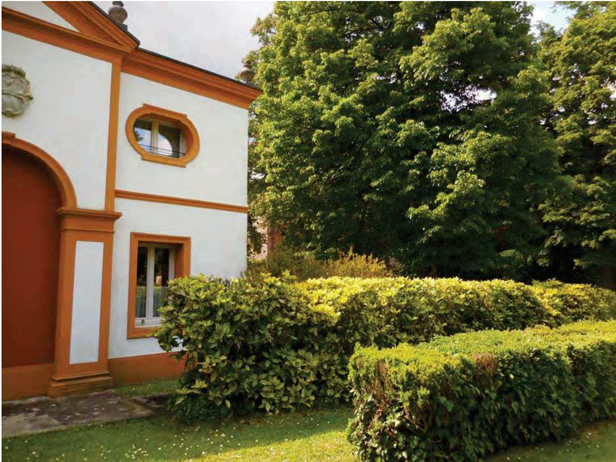
Foto 11 - vista esterna fabbricato dal parco facciata est
