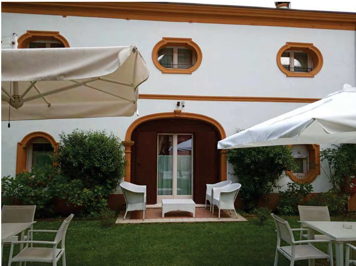
Foto 6 - vista esterna del fabbricato dal parco
