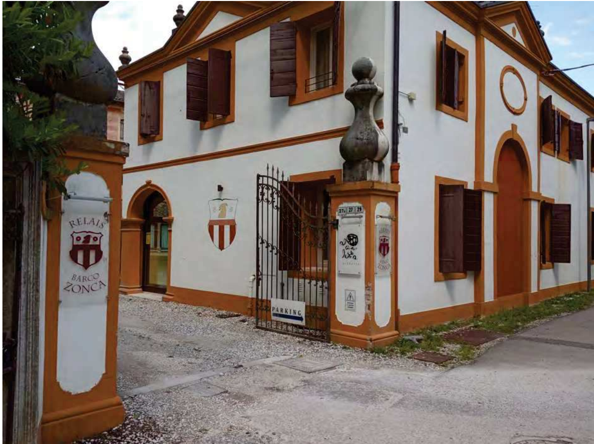
Foto 3 - vista esterna - accesso pedonale e carroia al fabbricato da Via Traversi
