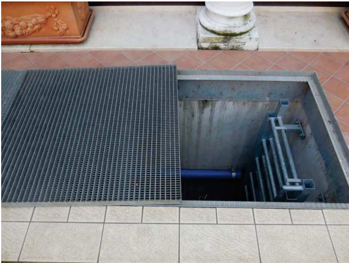
Foto 111 - bocca di lupo di accesso alla centrale termica
