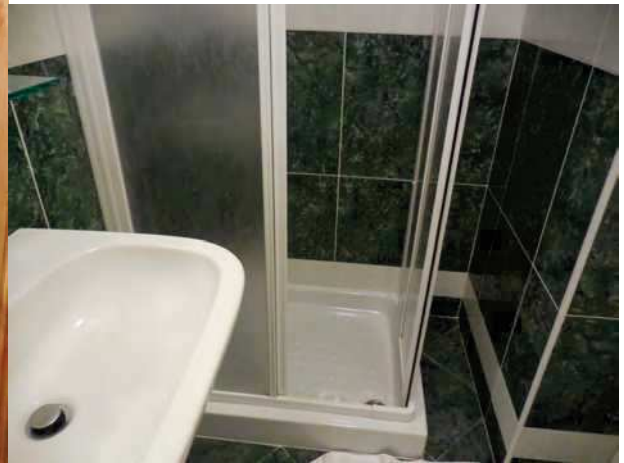
Foto 98 - piano primo – camera 110 - bagno
