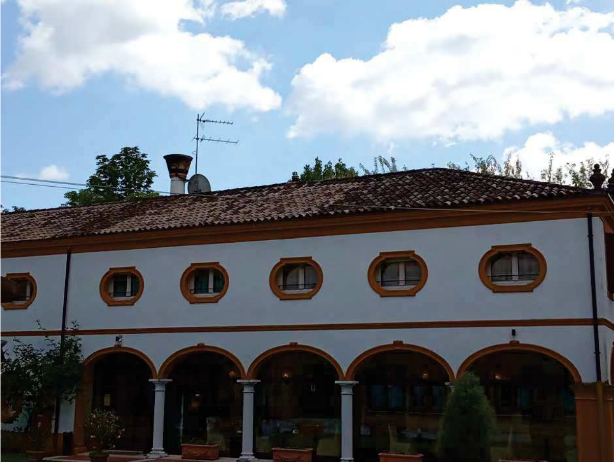
Foto 18 - vista esterna fabbricato dal parco facciata nord
