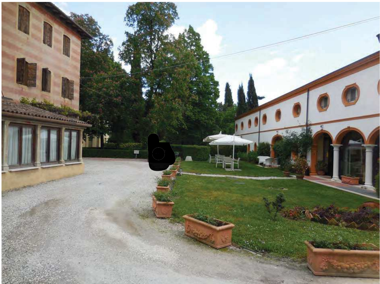
Foto 8 - vista esterna del fabbricato dal parco
