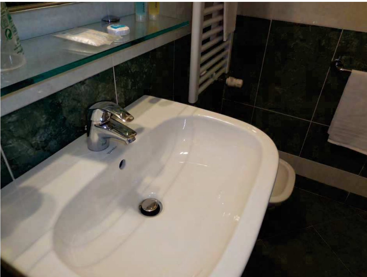
Foto 48 - piano terra – camera n. 03 - bagno
