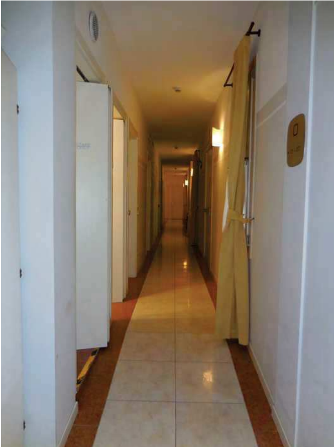
Foto 33 - piano terra – corridoio di accesso stanze
