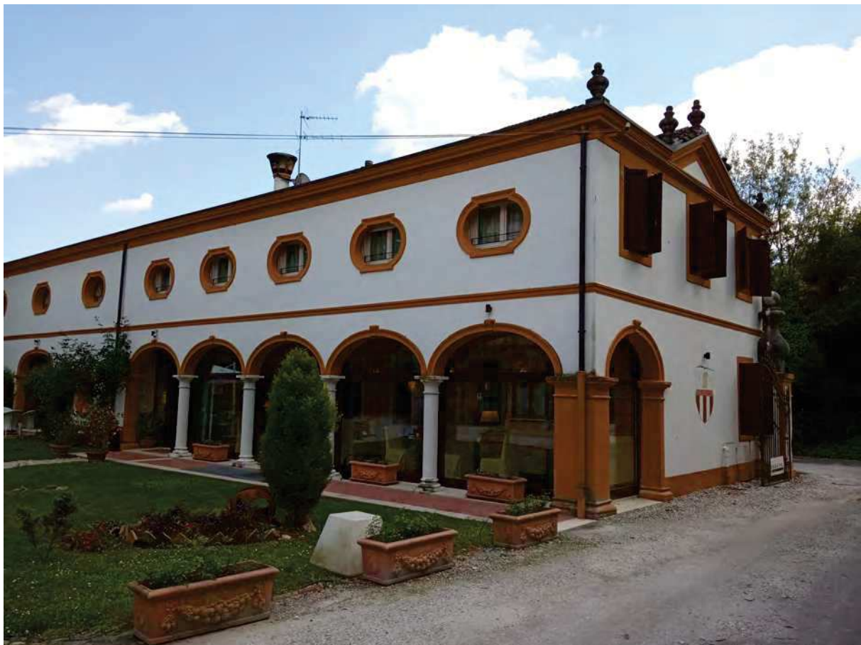
Foto 4 - vista esterna del fabbricato dal parco
