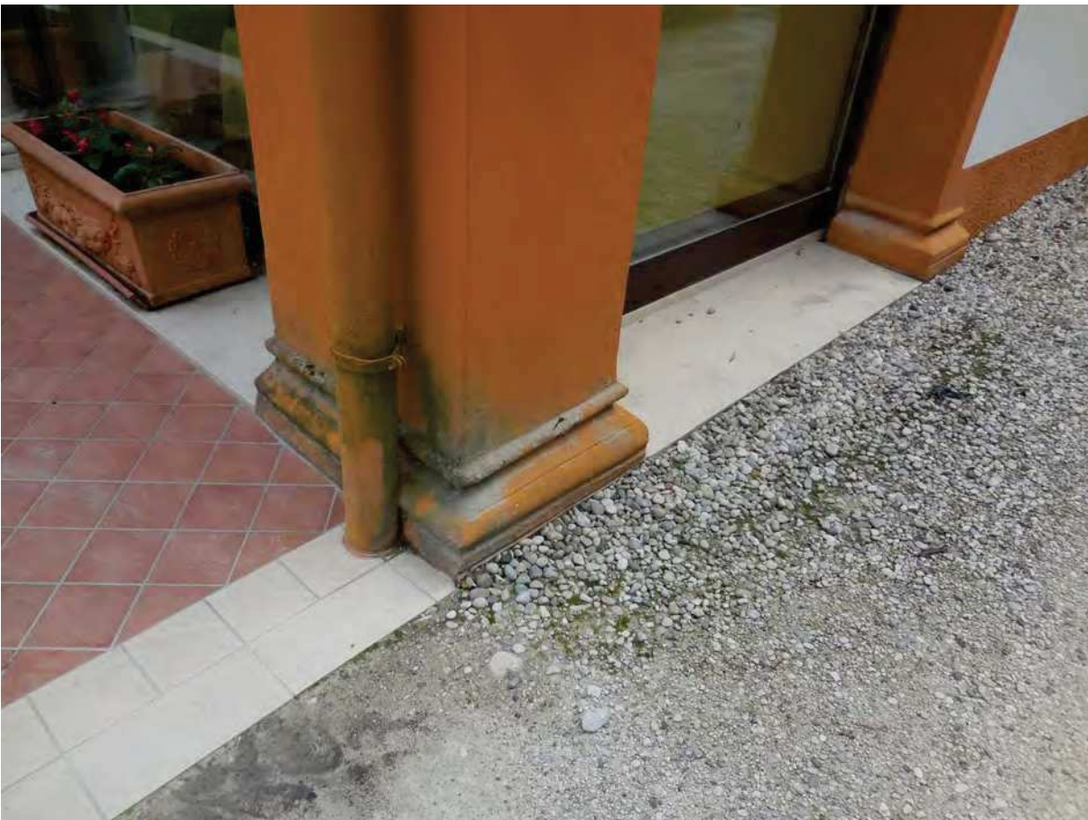
Foto 19 - vista esterna del fabbricato particolare angolo nord-ovest
