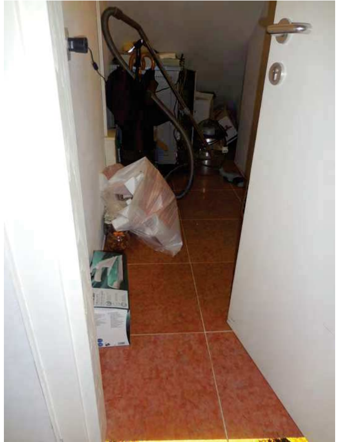
Foto 34 - piano terra – magazzino sottoscala
