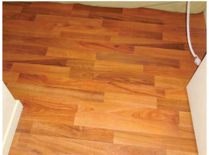
Foto 108 - piano primo – camera 114 _part . pavimento
