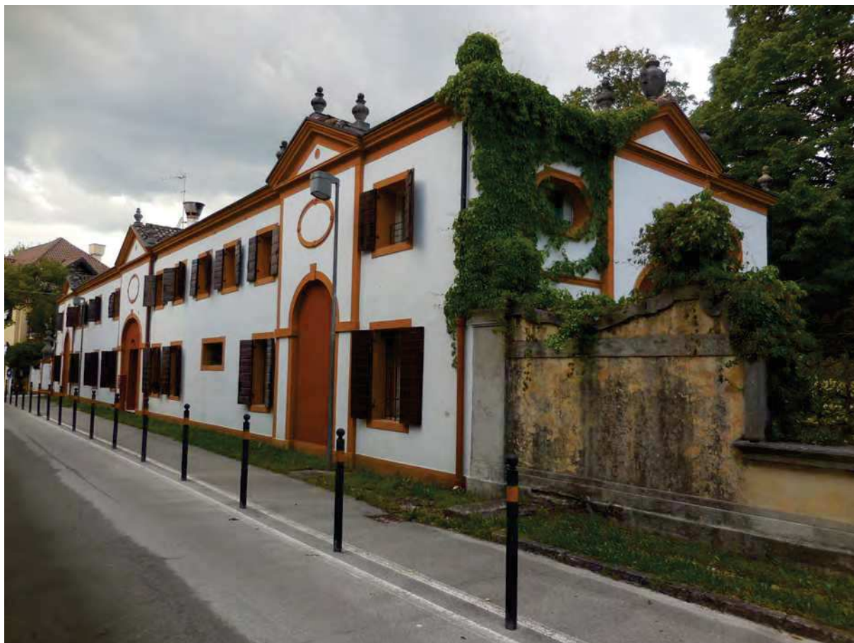
Foto 2 - vista esterna del fabbricato da Via Traversi
