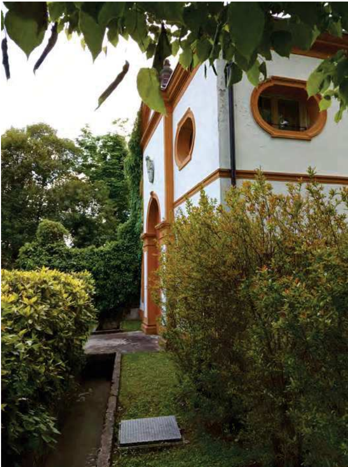
Foto 12 - vista esterna del fabbricato dal parco particolare fronte nord-est
