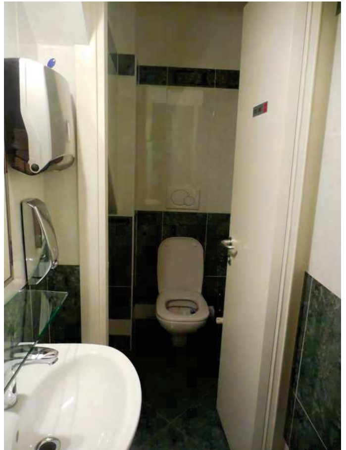
Foto 36 - piano terra – bagno
