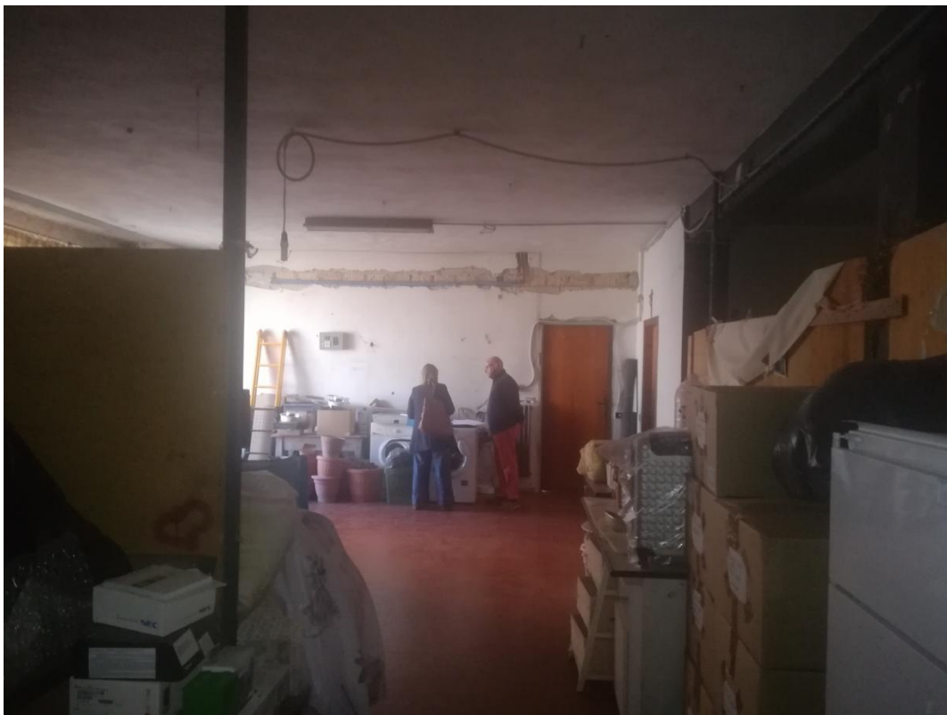
SUB. 24- PIANO TERRA : INTERNO DEL LOCALE ( VISTA INGRESSO DA VANO SCALA)
