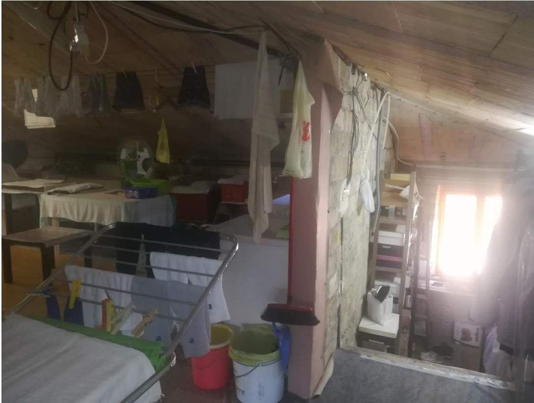
Sub. 24 - PIANO TERZO SOTTOTETTO : PORZIONE DI SOFFITTA
