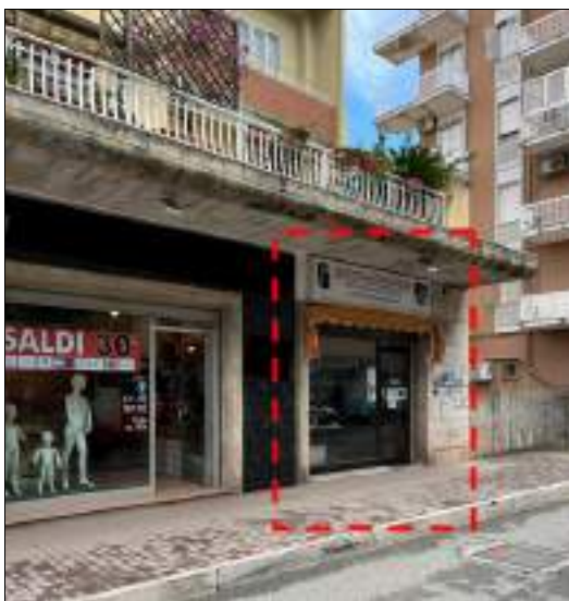
Fig. 20 – Bene sito in Comune di Soverato – Via Carlo Amirante
