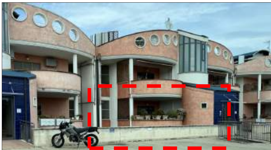
Fig. 15 – Foto fabbricato – Appartamento piano terra.
