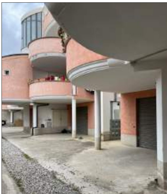
Fig. 16 – Foto fabbricato – piano seminterrato
