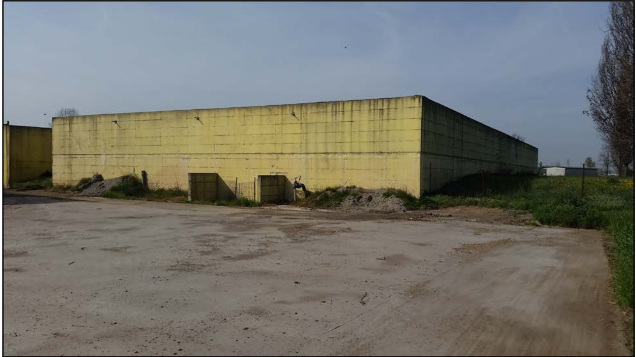
ESTERNO – VISTA SUD-EST
