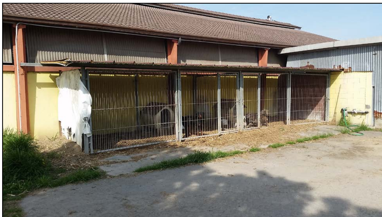
TETTOIA 1 – FRONTE SUD
