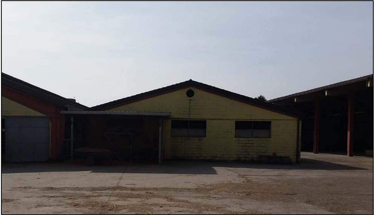
ESTERNO – FRONTE EST
