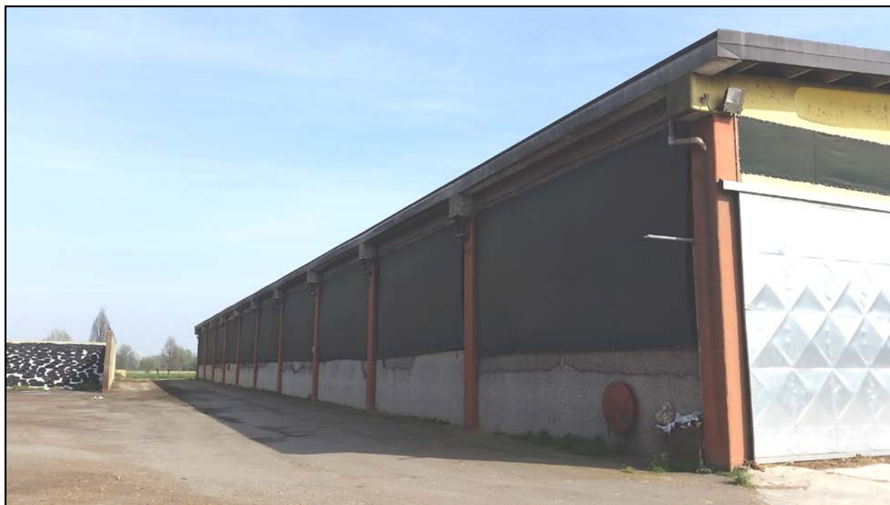
ESTERNO – FRONTE NORD
