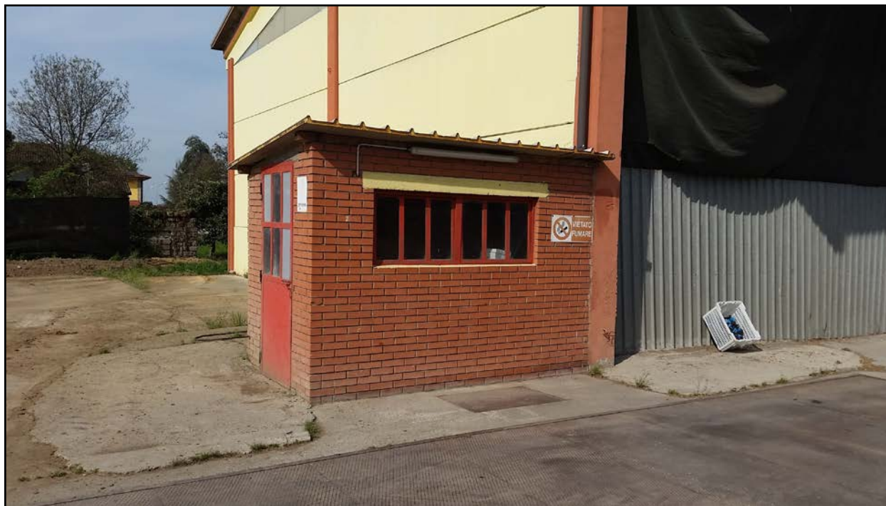
PESA – FRONTE SUD-OVEST
