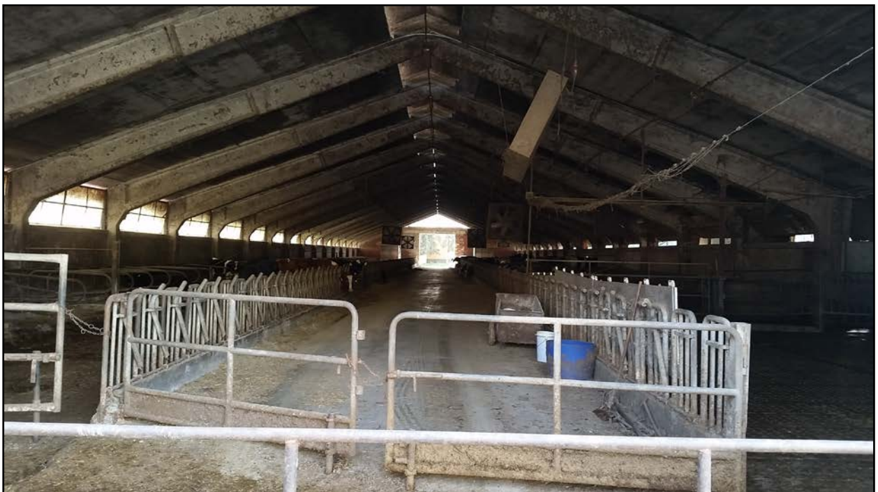
INTERNO – CORSIA DI FORAGGIAMENTO
