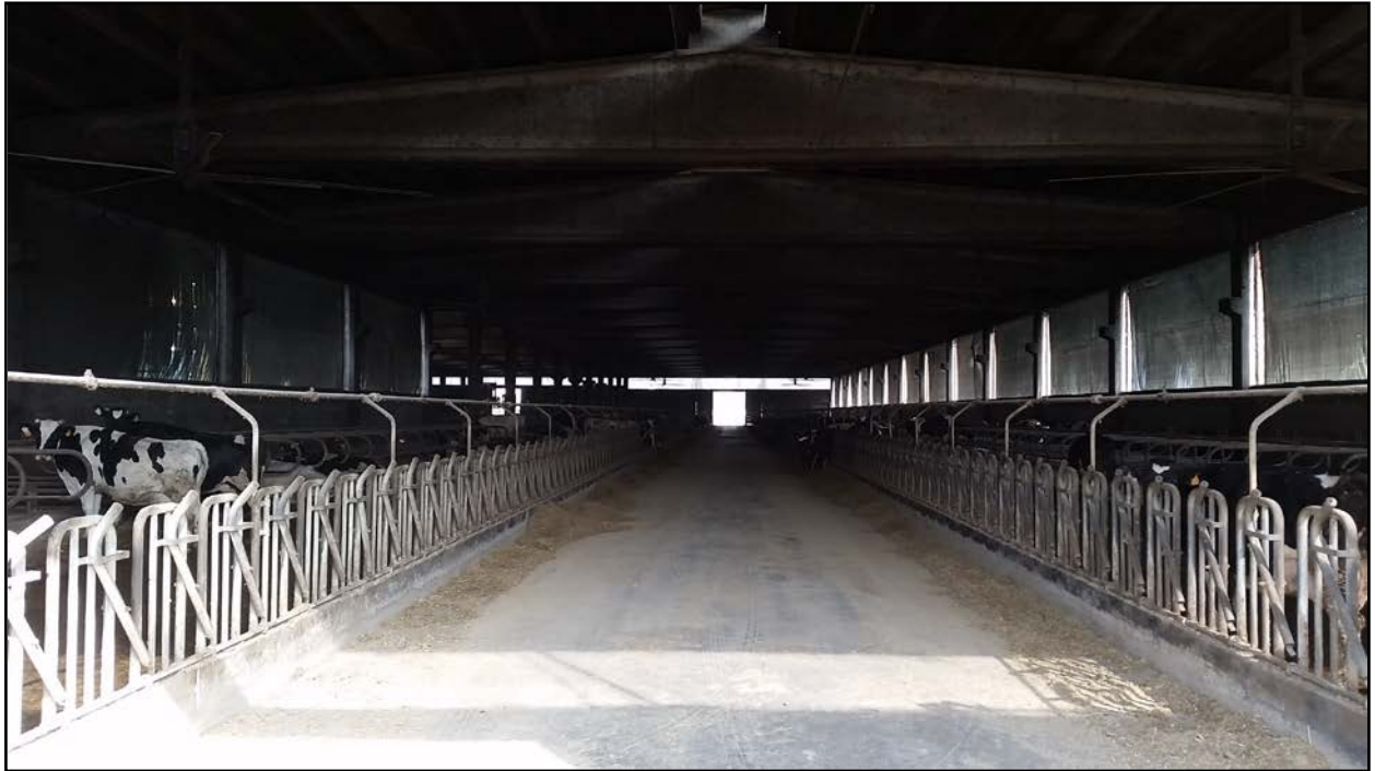
INTERNO – CORSIA DI FORAGGIAMENTO
