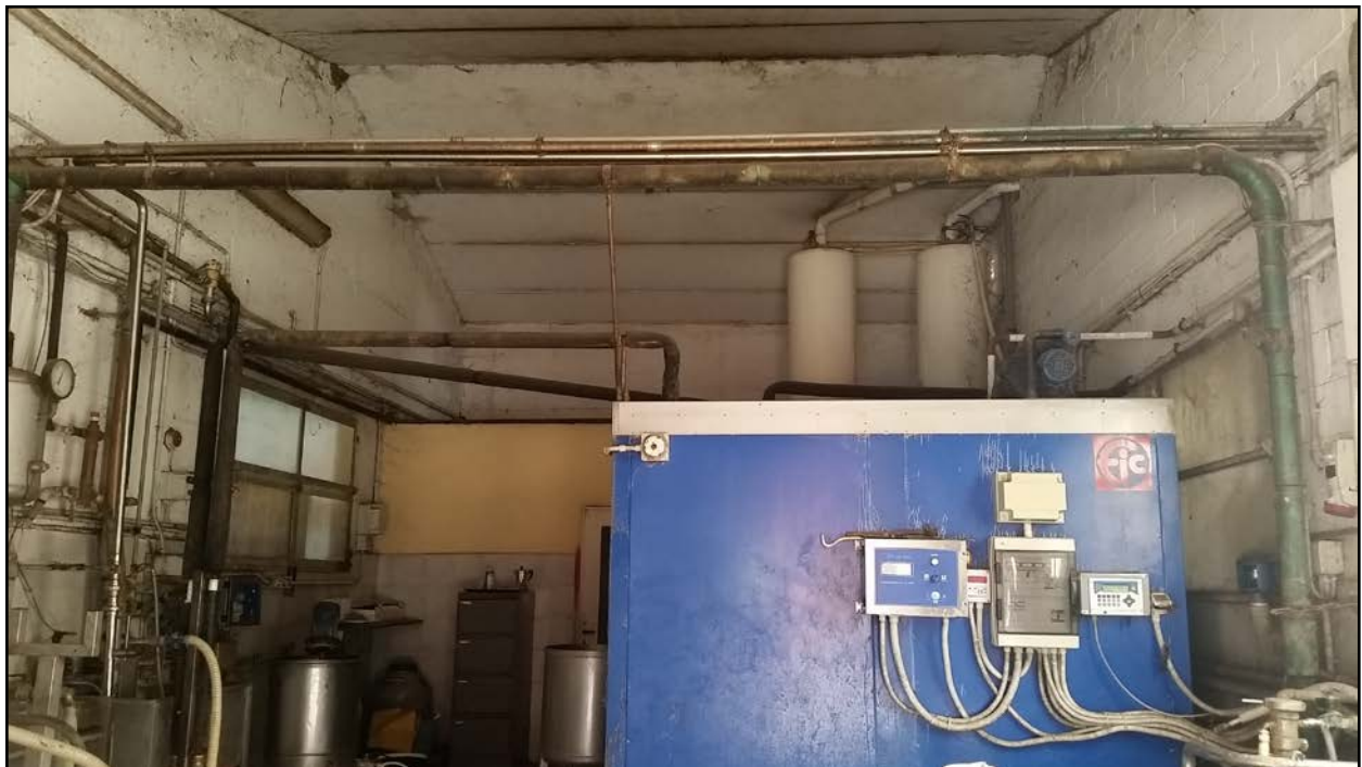
INTERNO – ZONA LATTE
