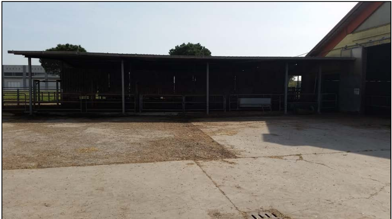
CAMMINAMENTO COPERTO – FRONTE NORD
